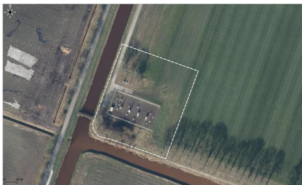
Figuur 2.4 Onderzoekslocatie afsluiter S-219.
