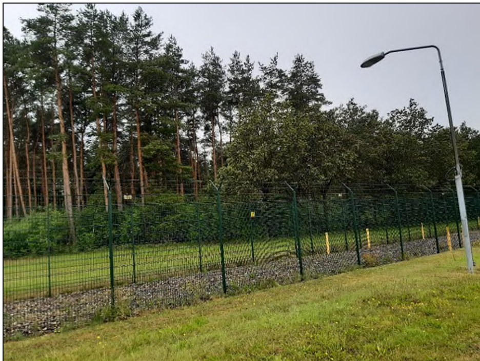
Foto 5. Impressie van het hekwerk rondom het station, gefotografeerd in oostelijke richting.
