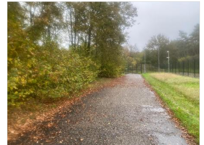
Figuur 2.5 Zicht op houtopstand binnen de hekken van het Compressorstation Ommen.
