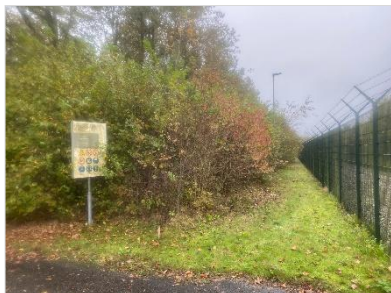
Figuur 2.6 Zicht op houtopstand binnen de hekken van het Compressorstation Ommen.
