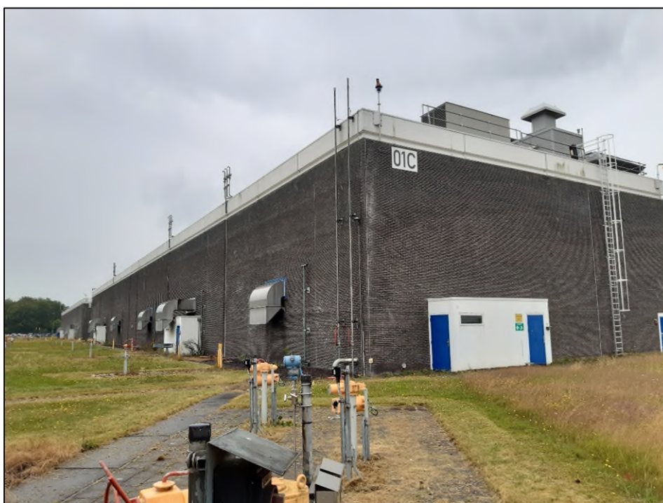
Foto 2. Zicht op de gebouwen 01C en 02C op het terrein van CS Ommen (A-401) waar er inpassende werkzaamheden plaatsvinden. De foto is gemaakt in westelijke richting.
