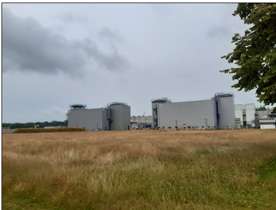
Foto 4. Overzicht van een deel van het veld met ondergronds leidingwerk waar werkzaamheden zijn voorzien en op de achtergrond de te slopen gebouwen (03C en 04C). De foto is gemaakt in zuidelijke richting.
