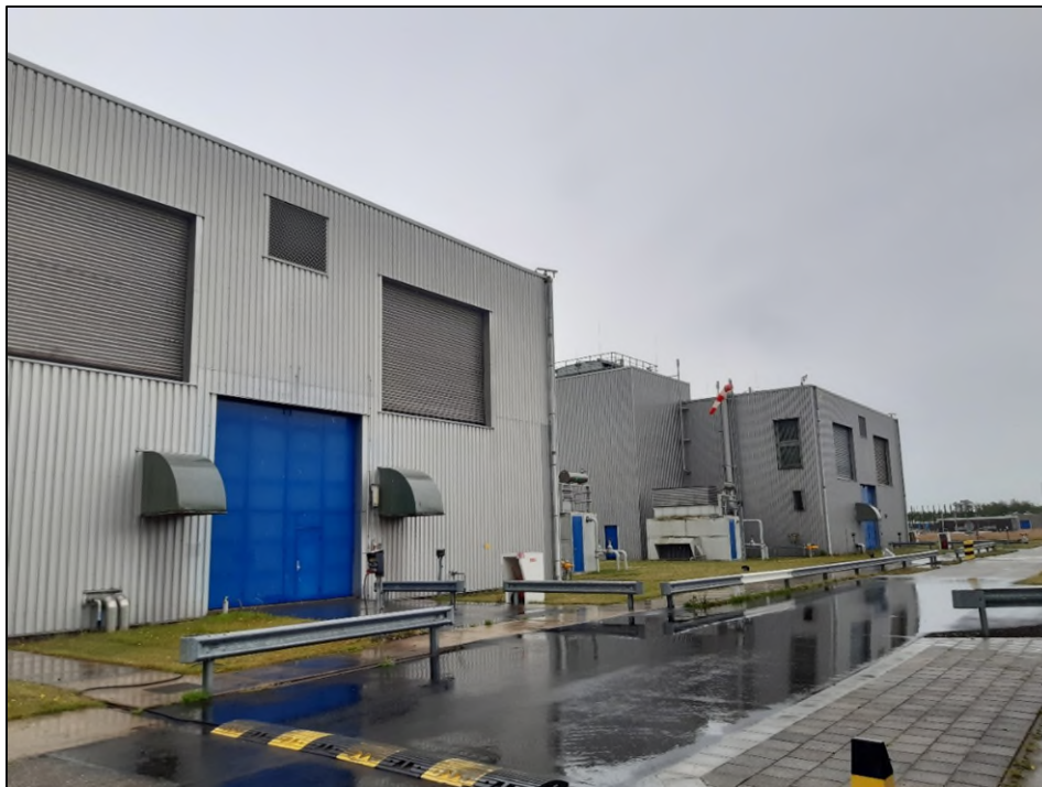
Foto 1. Zicht op de te slopen gebouwen 03C en 04C op het terrein van CS Ommen (A-401). De foto is gemaakt in oostelijke richting.
