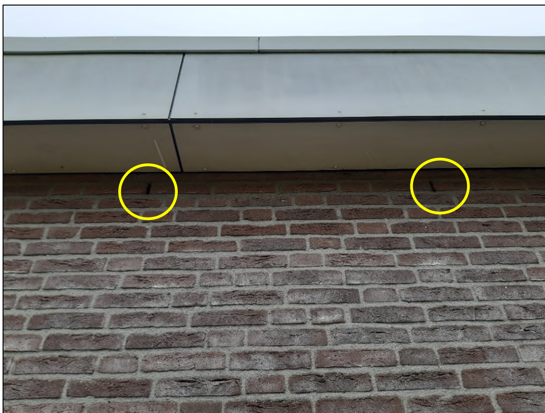
Foto 7. Open stootvoegen, zoals bij dit gebouw behorende tot compressorstation Ommen, bieden voor vleermuizen toegang tot achterliggende ruimtes en daarmee tot potentiële verblijfplaatsen.
