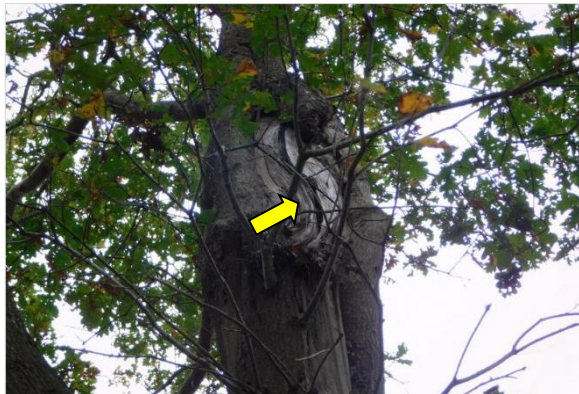
Figuur 4.5 Potentiële verblijfplaats voor boombewonende vleermuizen op de onderzoekslocatie.
