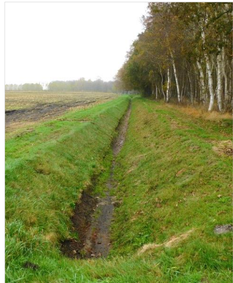
Figuur 4.9 Watergang langs de onderzoekslocatie.
