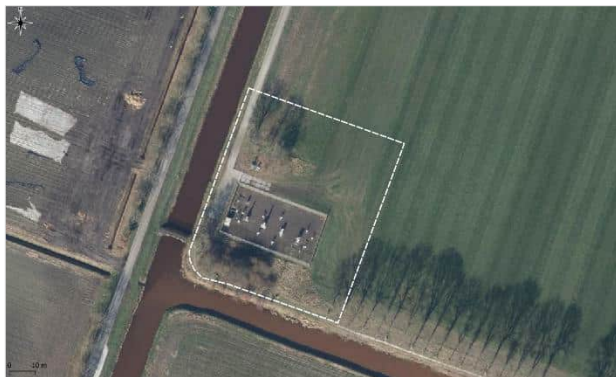
Figuur 2.4 Onderzoekslocatie afsluiter S-219.
