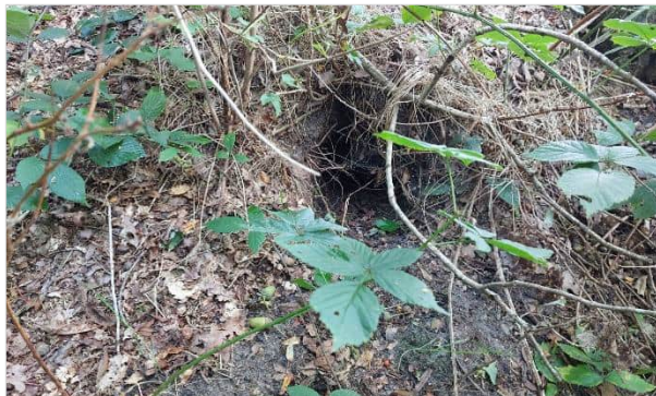
Figuur 5.6 (Oude) vluchtpijp in houtwal langs de zuidelijke grens van de onderzoekslocatie bij afsluiter S-440.
