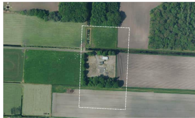
Figuur 2.5 Onderzoekslocatie afsluiter S-440.
