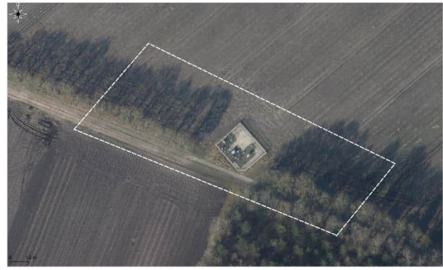
Figuur 2.3 Onderzoekslocatie afsluiter S-218.
