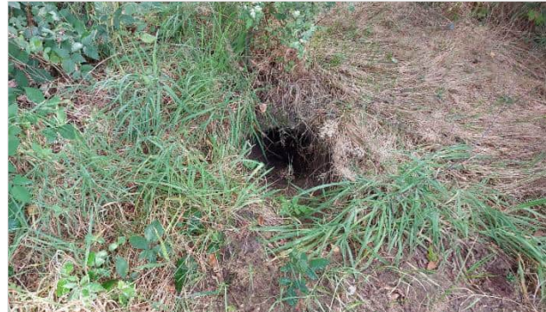
Figuur 5.7 (Oude) vluchtpijp in houtwal langs de zuidelijke grens van de onderzoekslocatie bij afsluiter S-440.
