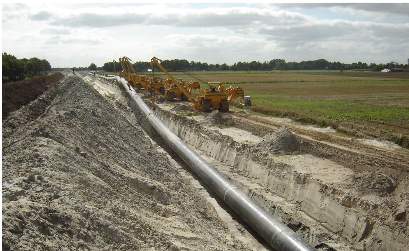
Figuur 3-5 Aanleg van buisleidingen in open ontgraving
