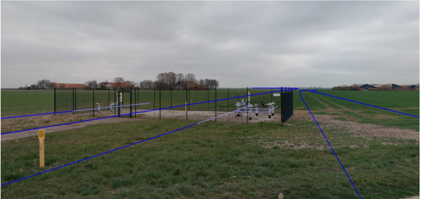
Figuur 3-1 Voorbeeld bestaande afsluiterlocatie voor aardgas S-135 Oostwold. De blauwe lijnen geven aan waar ondergronds de aardgasleidingen liggen
