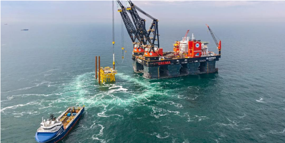
Installatie onderstel Hollandse Kust west Beta
