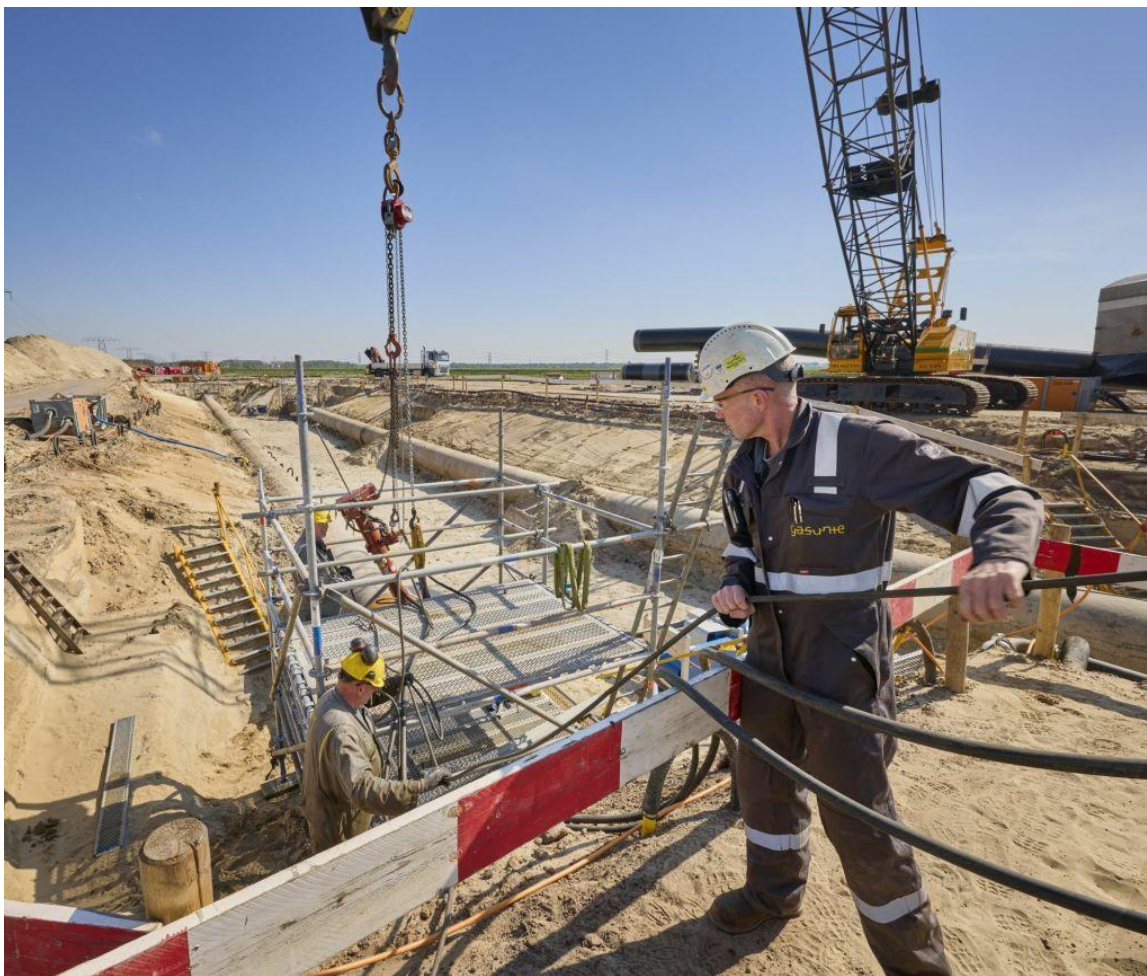
Figuur 5-24: Voorbeeld tie-in (voor een veel kleinere diameter leiding) (2)
