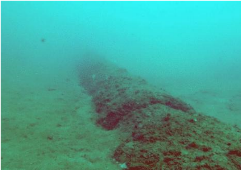
Figuur 3-1: Voorbeeld Pijpleiding ca. 60% begraven
