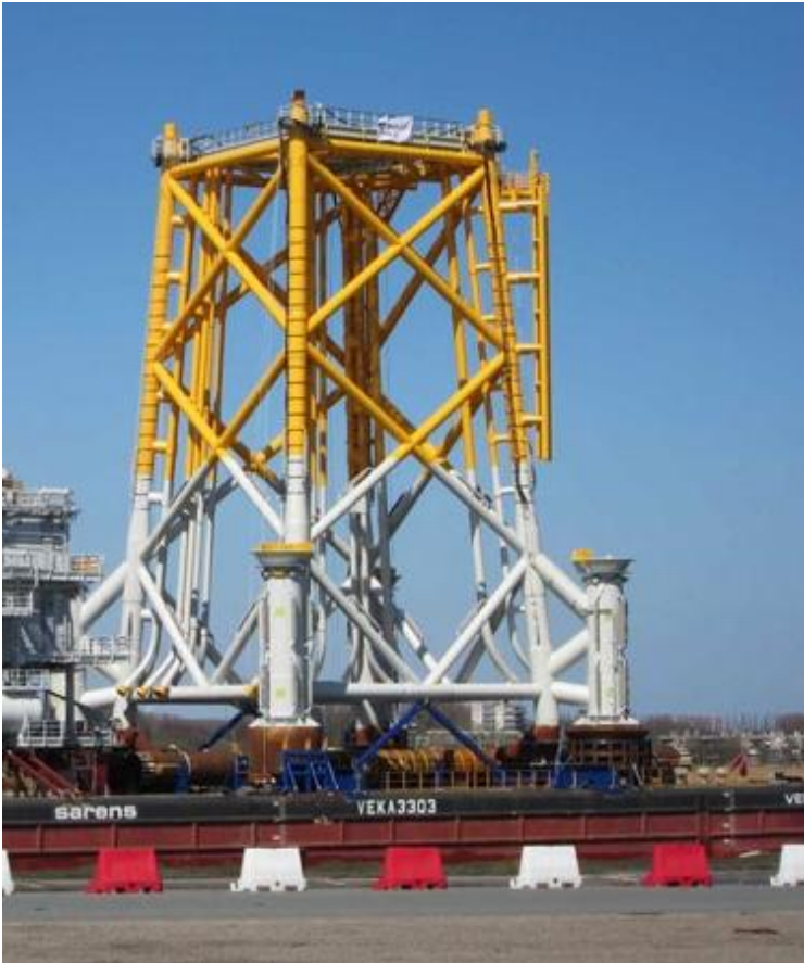
Figuur 5-7: Jacket met 4 poten ( https://www.smulders.com/en/offshore-wind )
