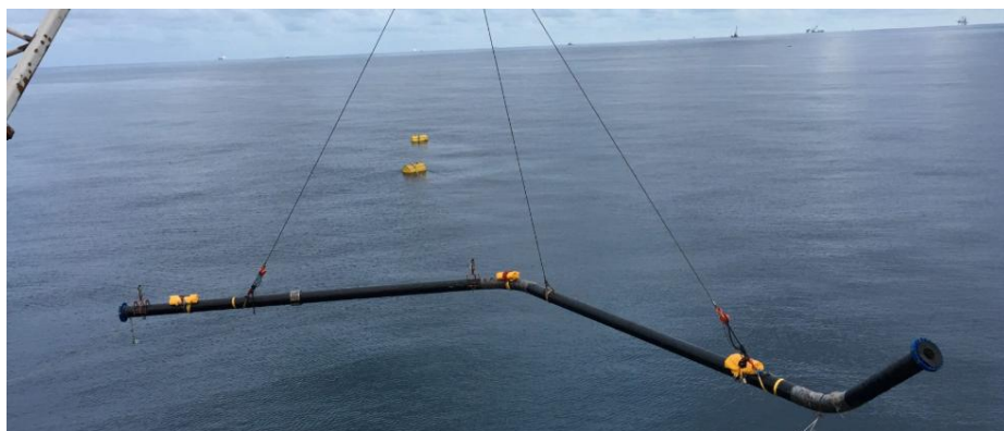
Figuur 5-16: Installatie van subsea spool
