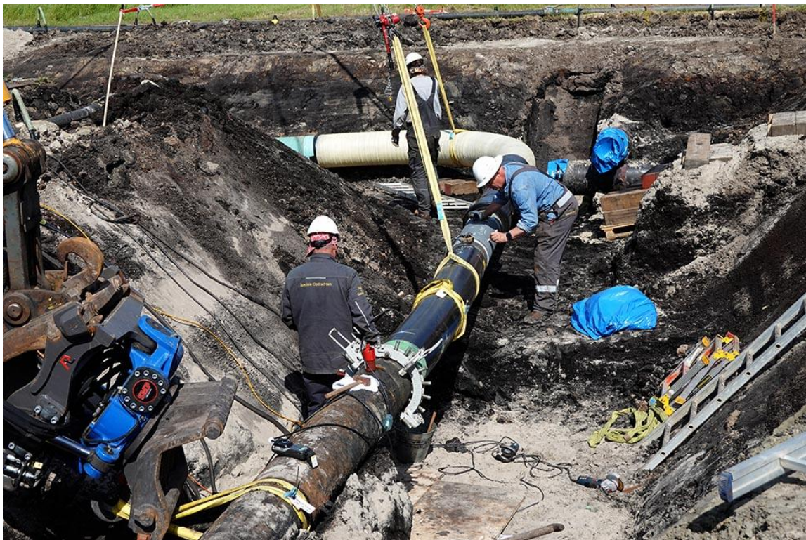
Figuur 5-23: Voorbeeld tie-in (voor een veel kleinere diameter leiding) (1)
