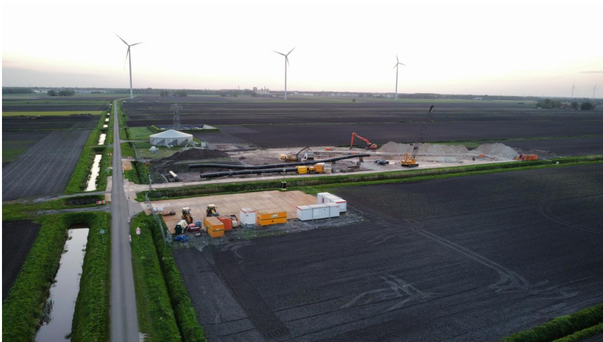
Figuur 5-25: Voorbeeld tie-in (voor een veel kleinere diameter leiding) (3)
