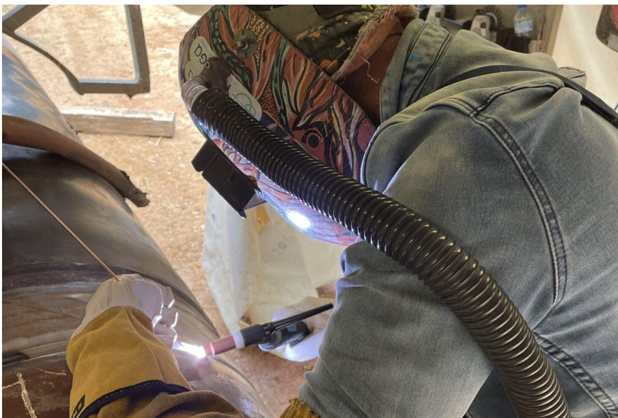
Figuur 5-22: Voorbeeld laswerkzaamheden
