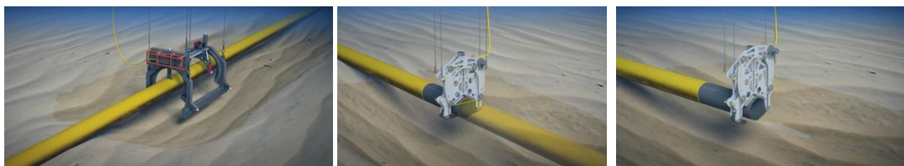
Figuur 5-10: Verwijderen pijpleidingsectie
