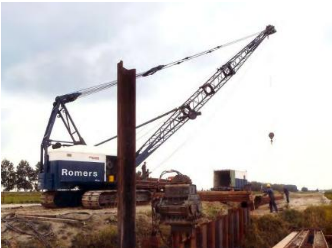
Figuur 4-8 Leiding in open ontgraving met damwand (bron: Hynetwork)
