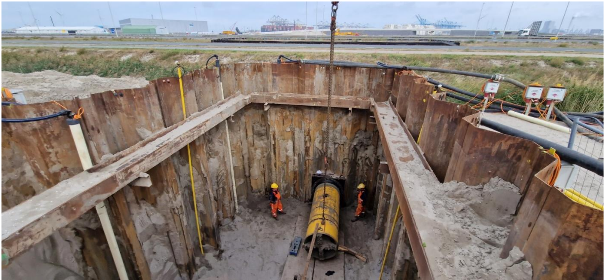
Figuur 4-10 Gesloten front boring
