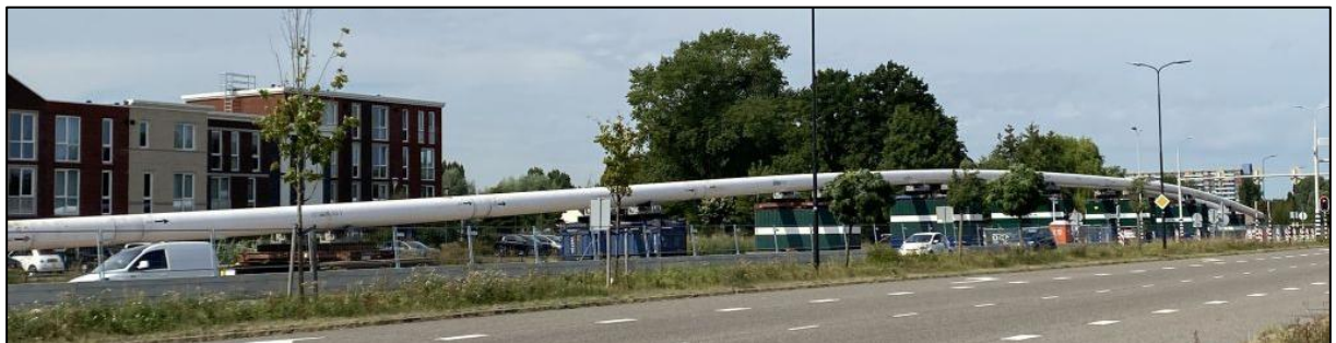
Figuur 4-9 Leiding die klaarligt voor een gestuurde boring (bron: Hynetwork, 2022)
