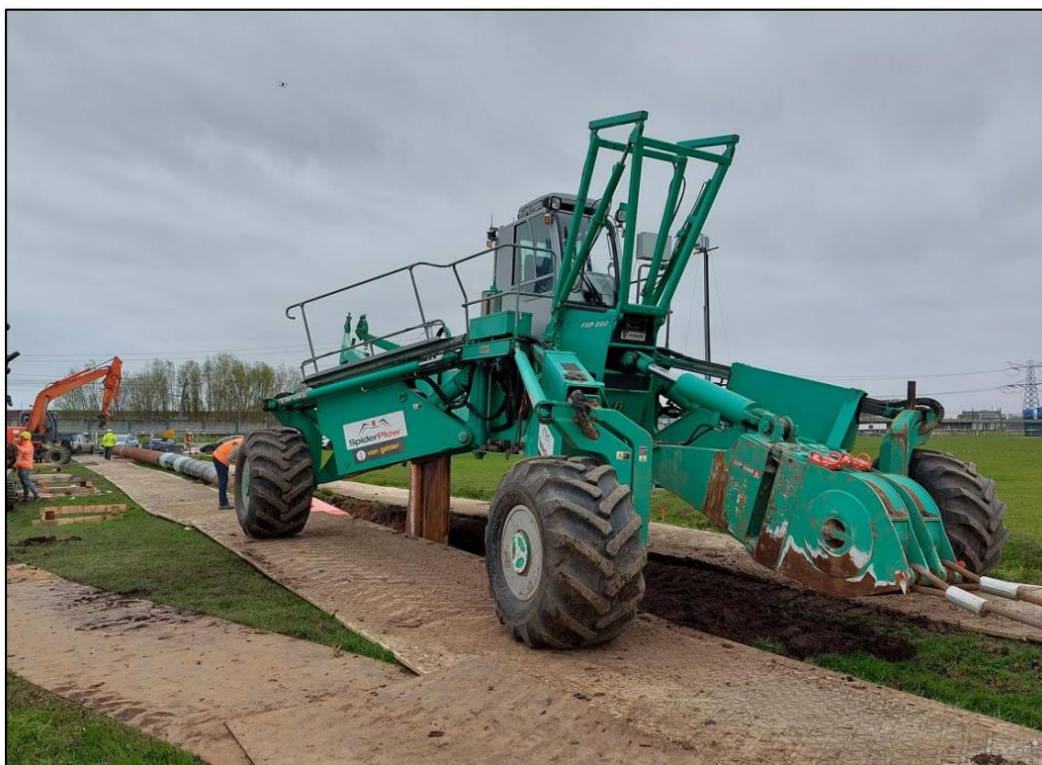
Figuur 4-11 Aanlegmethode inploegen
