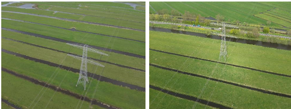
Figuur 7-7: Overzicht vanaf boven op de mastlocatie KIJ-DIM380 030 (links) en de mastlocatie KIJ-DIM380 033 (rechts, met in de achtergrond de Schoonhovenseweg; d.d.15 april 2025).
