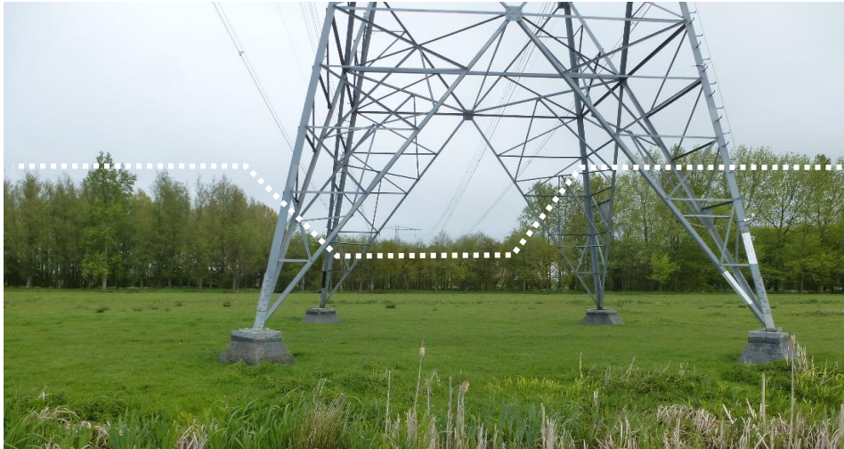
Figuur 7-8: Mastlocatie KIJ-DIM380 031 en zicht op het meer noordelijk gelegen NNN-beheertype N14.02 Hoog- en laagveenbos. Het beheer onder de ZRO onder de kabels in de masten is zichtbaar, doordat hier de opgaande structuur laag (of lager) wordt gehouden (zie witte stippellijn) dan buiten de ZRO-zone (d.d. 10 juni 2024).
