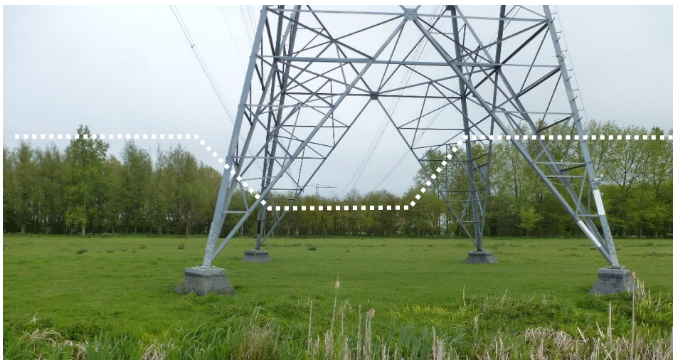
Figuur 3.11: Mastlocatie 031 en zicht op het meer noordelijk gelegen NNN-natuurtype N14.02 Hoog- en laagveenbos. Het beheer onder de ZRO onder de kabels in de masten is zichtbaar, doordat hier de opgaande structuur laag (of lager) wordt gehouden (zie witte stippellijn) dan buiten de ZRO-zone (d.d. 10 juni 2024).
