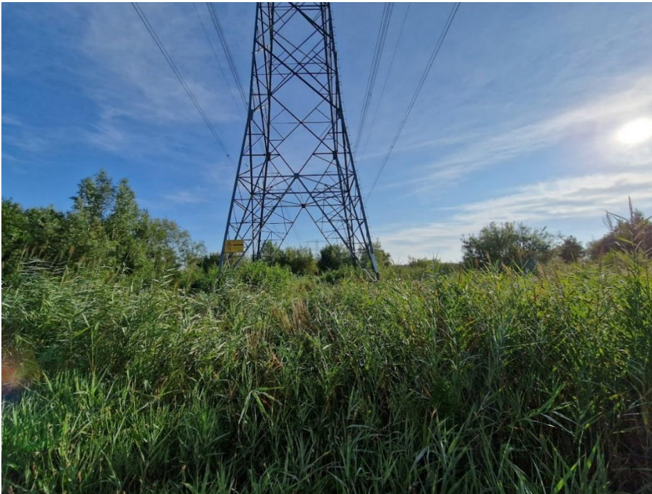
Figuur 3.24: Zijaanzicht op mastlocatie 079 (opname tijdens vaatplantenonderzoek, d.d. 24 juli 2025).
