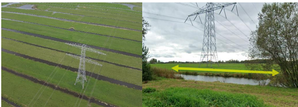
Figuur 3.10: Overzicht vanaf boven op de mastlocatie 030 (links; d.d.15 april 2025) en zij aanzicht van de mastlocatie 033 (rechts; Google Streetview). Met gele pijl is de oever N05.03 aangeduid.
