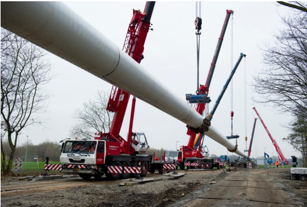
Figuur 3-20 Gestuurde boring warmteleiding 900 mm project Leiding over Noord, bron Eneco
