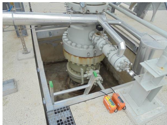
foto 2: Detail well Head gasproductie/injectie caverne A3
