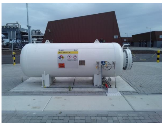
foto 1: Bovengrondse buffertank
