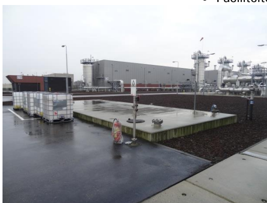
foto 1: Los/laadplaats open drains
