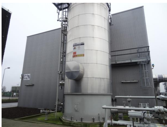
foto 1: Expansievat
