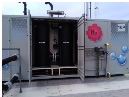
foto 2: Electrolyser
