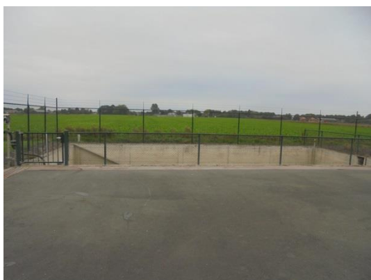
foto 1: Vuilwaterput / calamiteitenbak verharding
