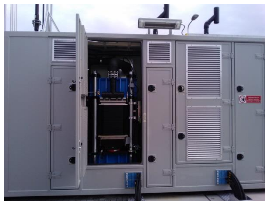
foto 4: Electrolyser
