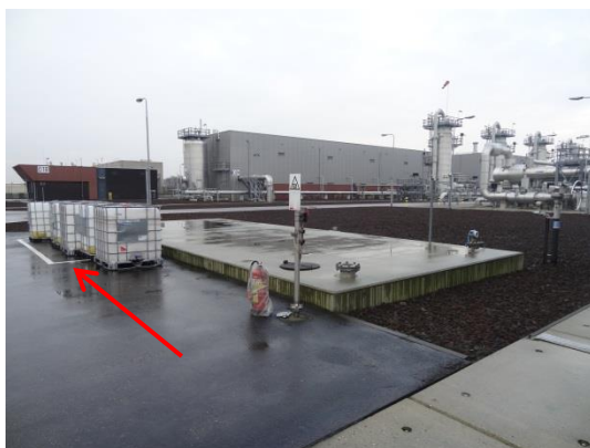
foto 1: Opslagplaats IBC vaten
