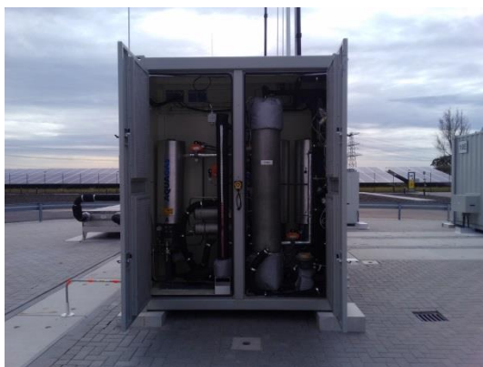
foto 3: Electrolyser
