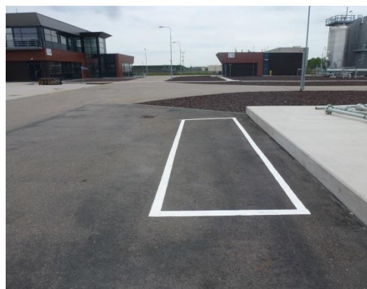
foto 2: Opslagplaats IBC vaten (d.d. 16-05-2017)
