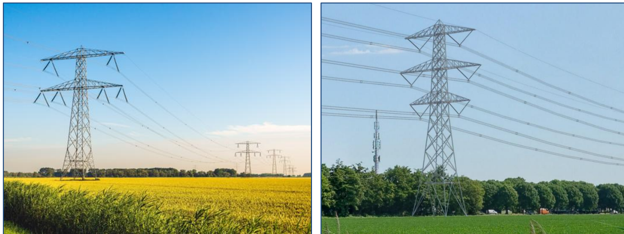
Figuur 6 Op de linker afbeelding zijn donaumasten te zien, op de rechter een moldaumast
