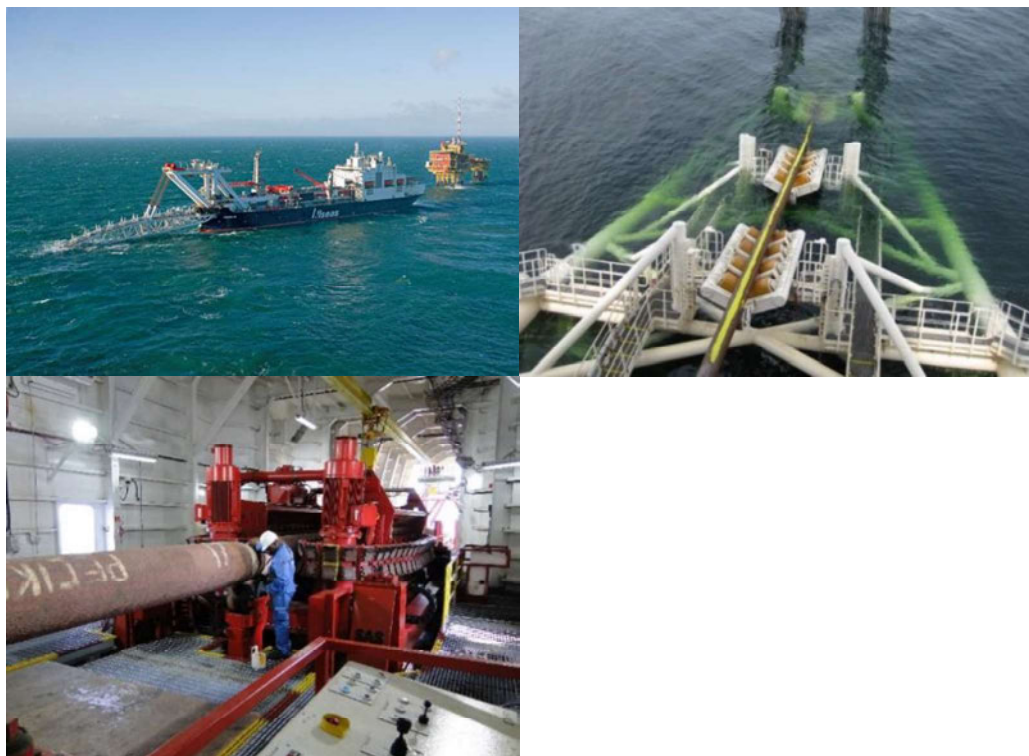
Figuur 7: Verwijderen van pijpleidingen met behulp van reverse S-Lay
