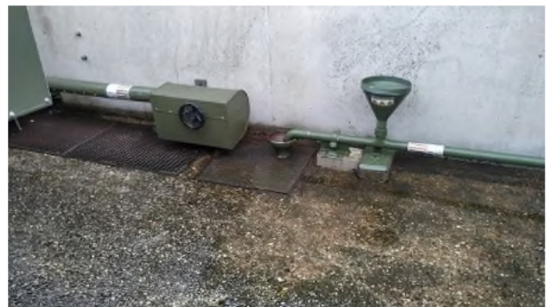
Fotonummer: 4 Omschrijving: Diverse funnels, drains en flenskoppelingen.
