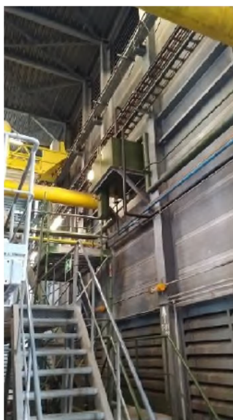
Fotonummer: 4 Omschrijving: Bovengronds opgesteld olievat voor bevoorrading compressor.
