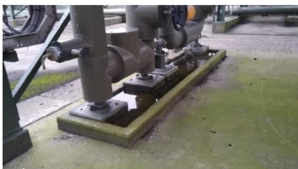
Fotonummer: 3 Omschrijving: Voorziening betonvloer met opstaande randen.
