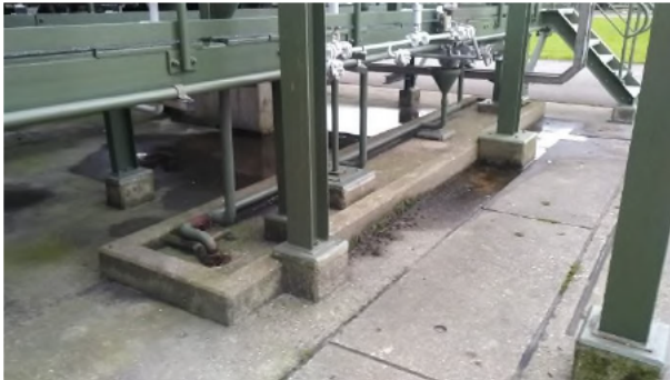
Fotonummer: 1 Omschrijving: Betonvloer met opstaande randen.
