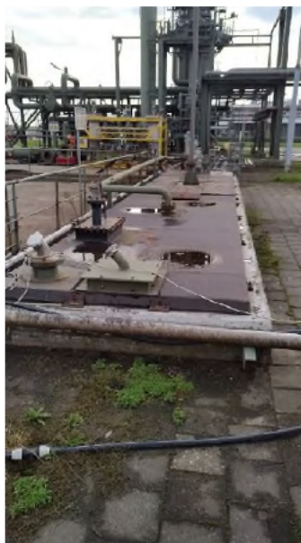
Fotonummer: 4 Omschrijving: Opvangbak industrieel afvalwater.
