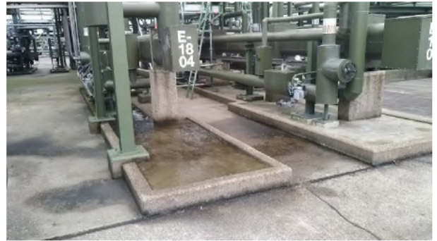
Fotonummer: 2 Omschrijving: Betonvloer met opstaande randen.
