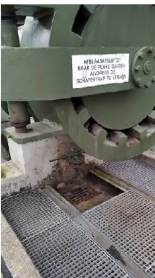
Fotonummer: 5 Omschrijving: Vloer onder scraper ontvangstinrichting met afvoerpunt.
