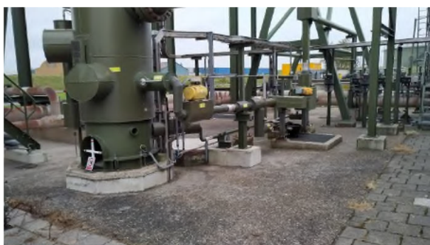
Fotonummer: 5 Omschrijving: Opgestelde installatie onderdelen.
