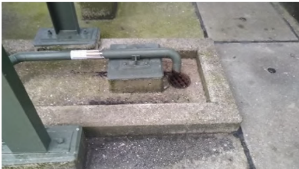
Fotonummer: 3 Omschrijving: Betonvloer met opstaande randen en afvoerpunt.
