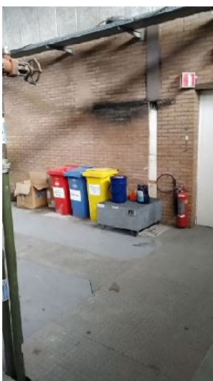
Fotonummer: 5 Omschrijving: Opslag vloeistoffen in emballage boven lekbak.
