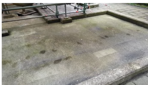
Fotonummer: 4 Omschrijving: Aanwezige betonvloer met opstaande randen.
