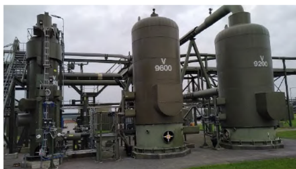
Fotonummer: 6 Omschrijving: Opgestelde installatie onderdelen.
