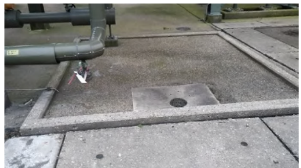
Fotonummer: 4 Omschrijving: Drainpunt/ afvoerpunt.
