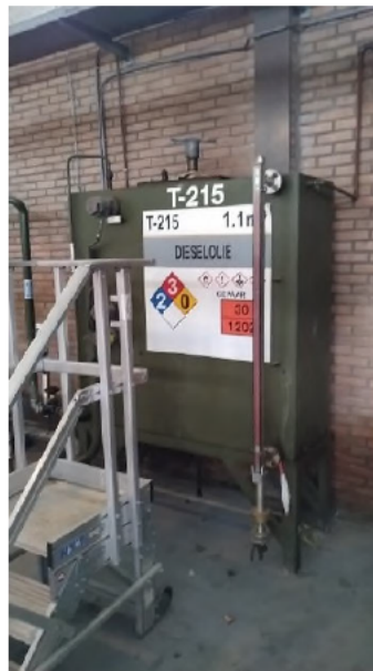
Fotonummer: 4 Omschrijving: Bovengrondse opslagtank voor bevoorrading noodgenerator.
