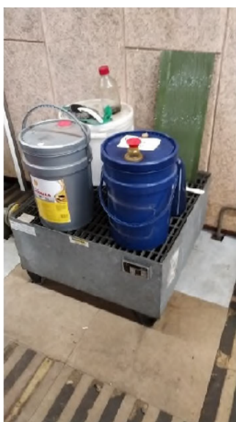
Fotonummer: 5 Omschrijving: Opslag boven lekbakken.
