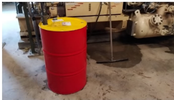
Fotonummer: 4 Omschrijving: Vloeistofvat plaatsen op lekbak.
