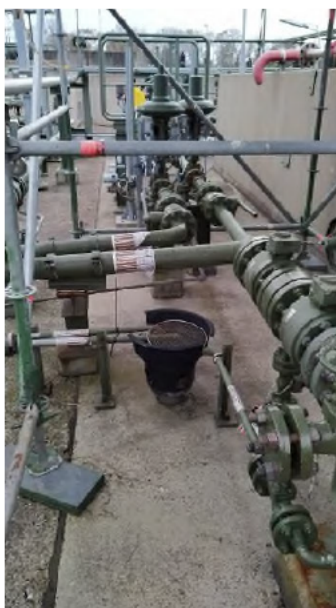
Fotonummer: 4 Omschrijving: Diverse funnels, afsluiters en flenskoppelingen.
