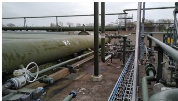
Fotonummer: 2 Omschrijving: Slugcatcher Local en HiCal.
