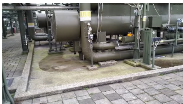
Fotonummer: 2 Omschrijving: Aanwezige betonvloer met opstaande randen.
