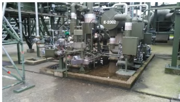
Fotonummer: 2 Omschrijving: Voorziening betonvloer met opstaande randen.
