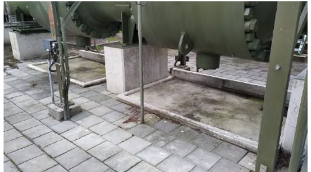
Fotonummer: 2 Omschrijving: Betonnen vloeren onder tappunten condensaat.
