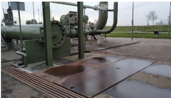
Fotonummer: 3 Omschrijving: Vloer onder scraper ontvangstinrichting met roostergoot.
