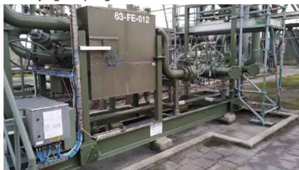
Fotonummer: 4 Omschrijving: Opvangbak industrieel afvalwater.
