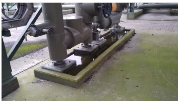
Fotonummer: 3 Omschrijving: Voorziening betonvloer met opstaande randen.
