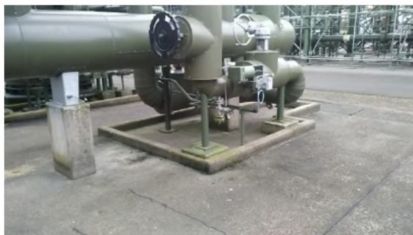
Fotonummer: 2 Omschrijving: Voorziening betonvloer met opstaande randen.
