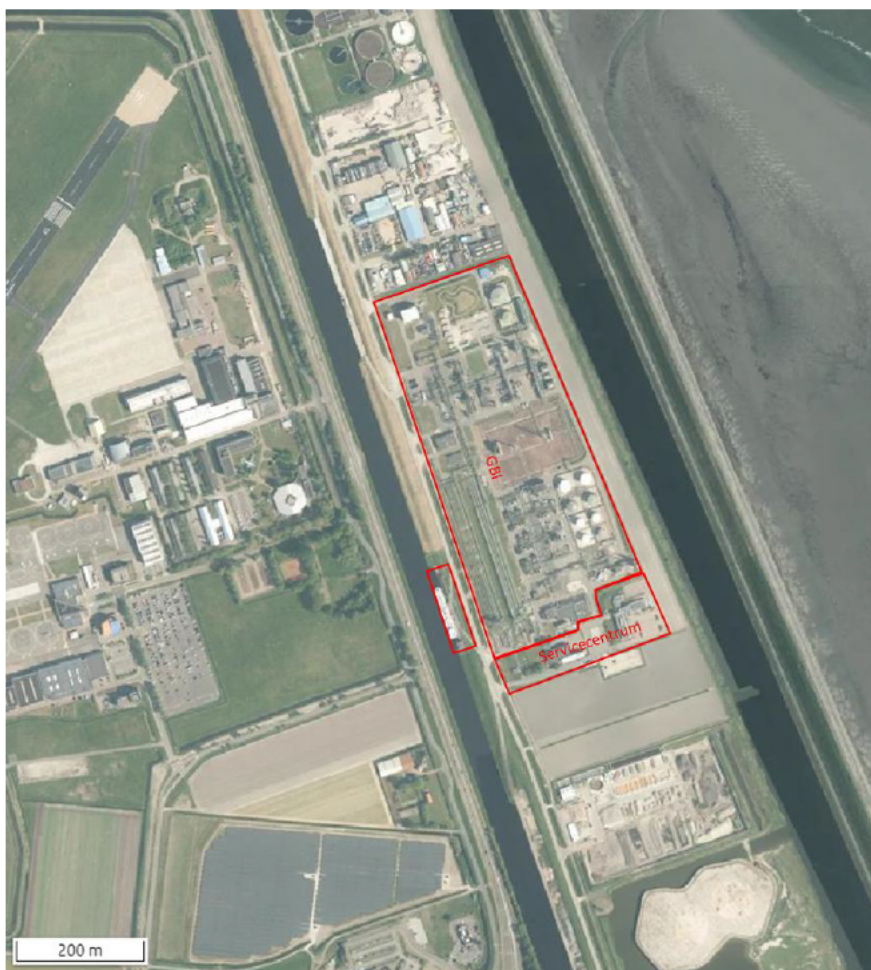
Figuur 1-3. Overzichtsfoto GBI Den Helder bestaande uit de inrichting GBI Den Helder, GBI Den Helder (incl. loswal) en het servicecentrum zijn rood omlijnd.
