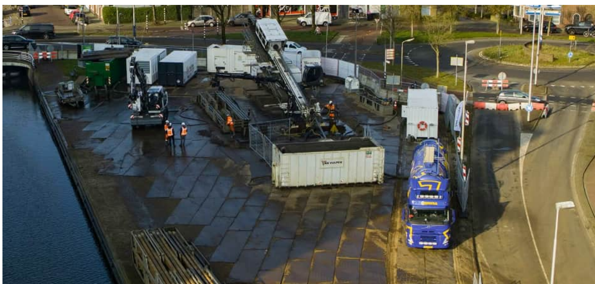
Figuur 21: Afbeelding 200T boorstelling op werklocatie
