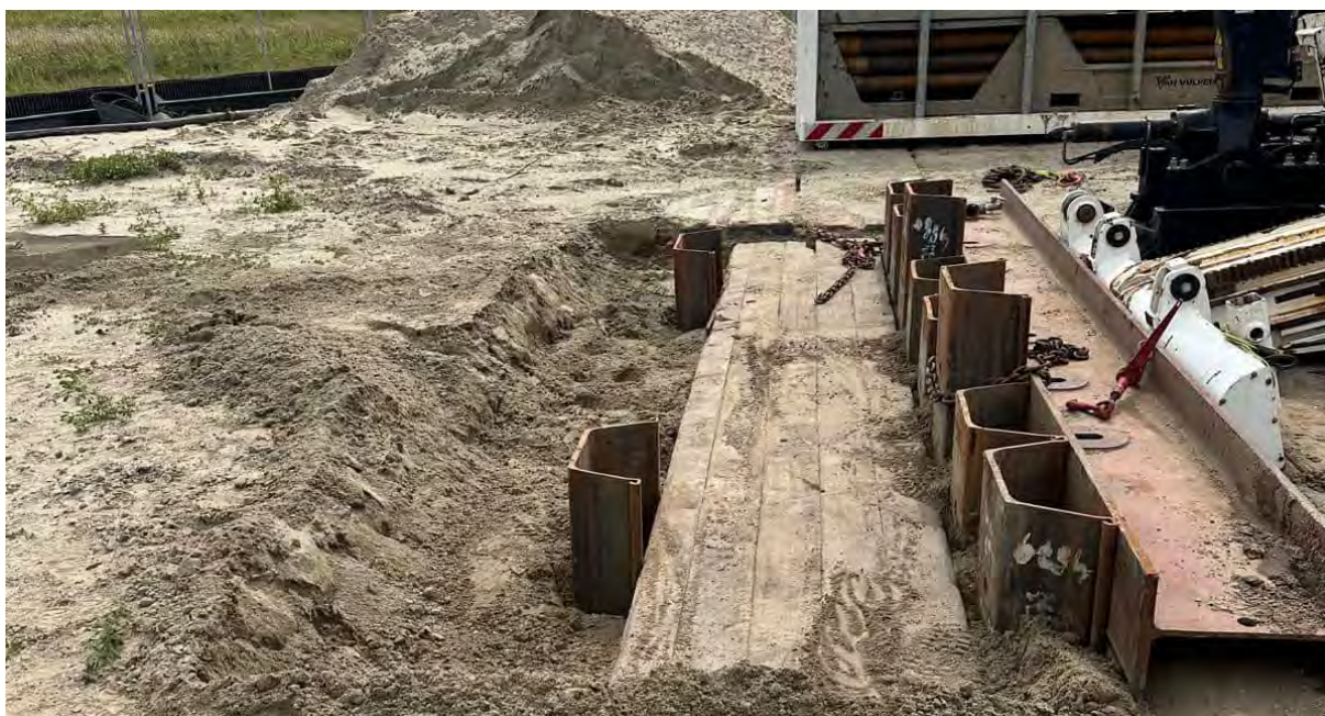
Figuur 17: Voorbeeld toegepaste verankeringswand
