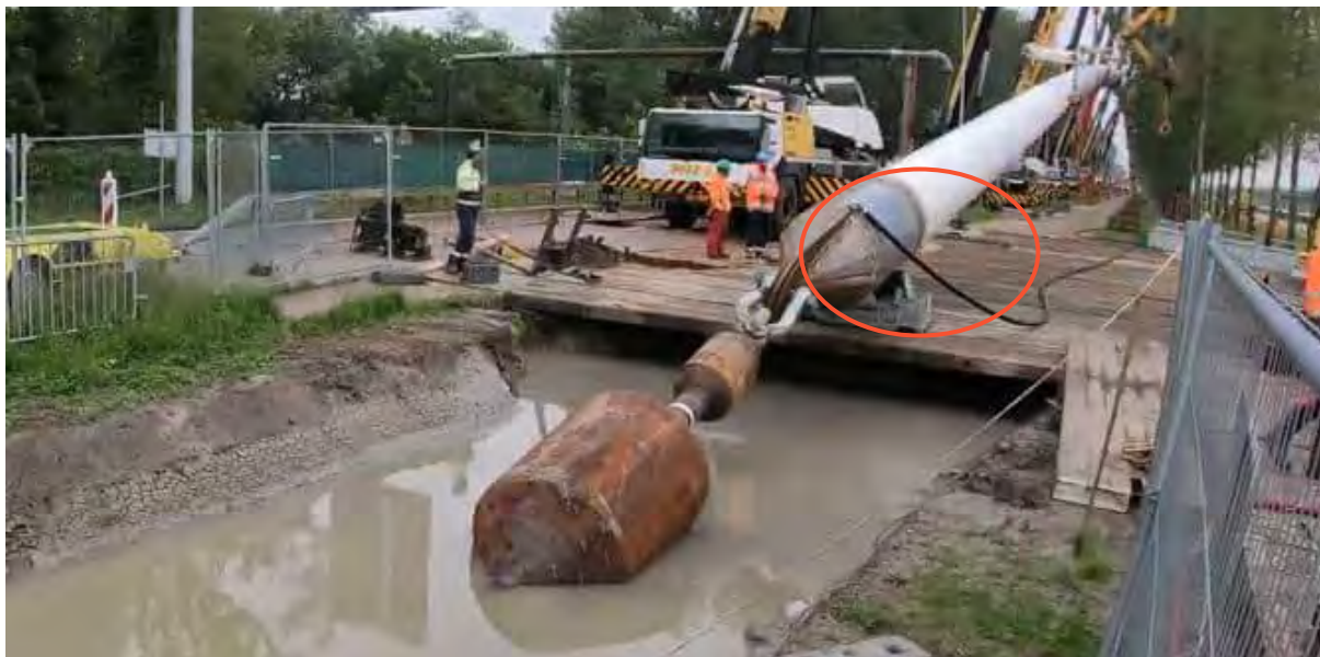
Figuur 21: Vulleiding t.b.v. achteraf aanbrengen Drill-Grout bij DN1050 leiding Porthos.
