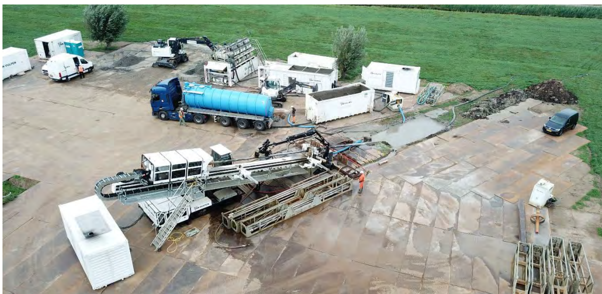
Figuur 20: Afbeelding 300T boorstelling op werklocatie
