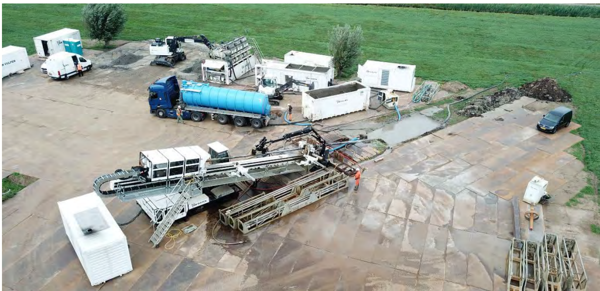
Figuur 17: Afbeelding 300T boorstelling op werklocatie
