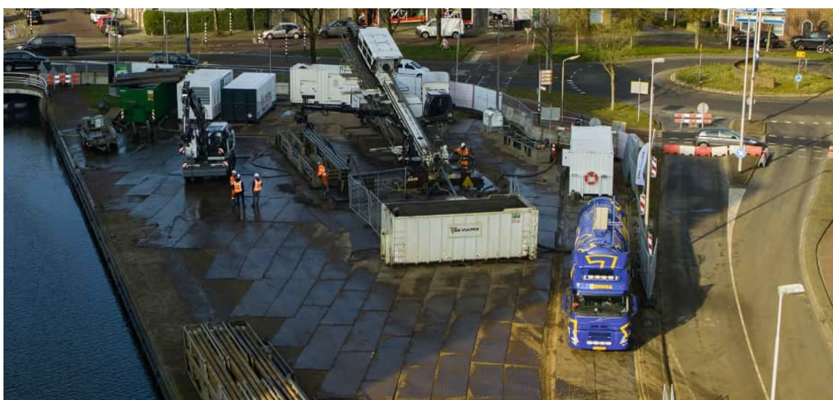
Figuur 18: Afbeelding 200T boorstelling op werklocatie
