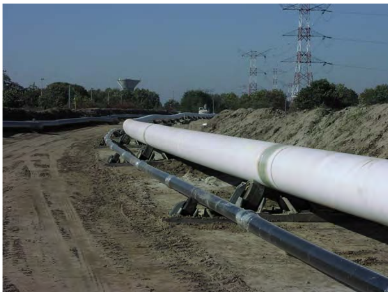
Foto 2 : 24" (600 mm) gastransportleiding gereed voor intrekken met HDD (Peer, België, 2003)
