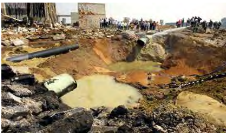
Foto 3 Ontgrondingskrater na breuk en grote brand gastransportleiding te Gellingen (Ghislengien), België, 2004
