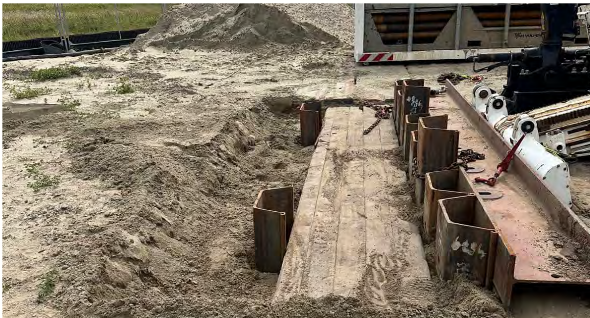
Figuur 17: Voorbeeld toegepaste verankeringswand
