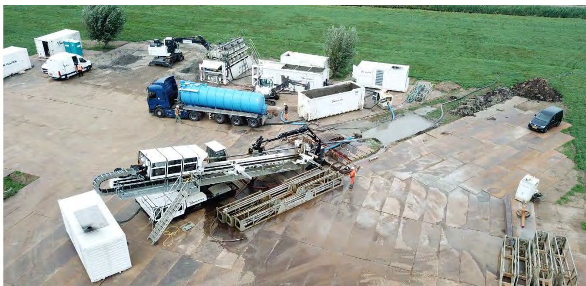
Figuur 18: Afbeelding 300T boorstelling op werklocatie
