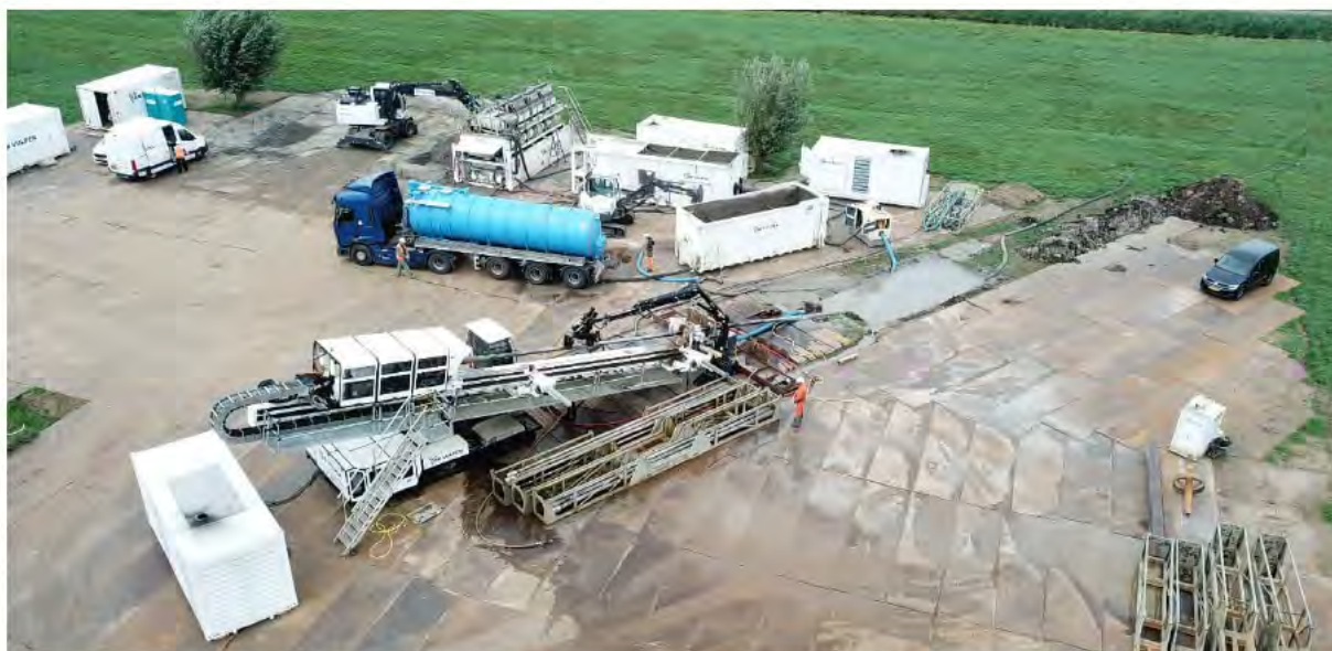
Figuur 20: Afbeelding 300T boorstelling op werklocatie
