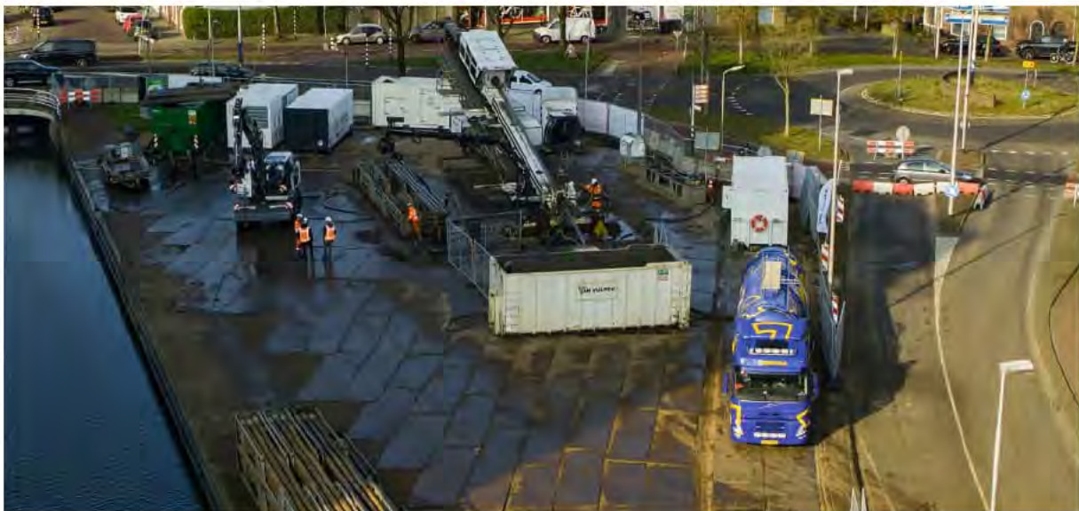
Figuur 21: Afbeelding 200T boorstelling op werklocatie
