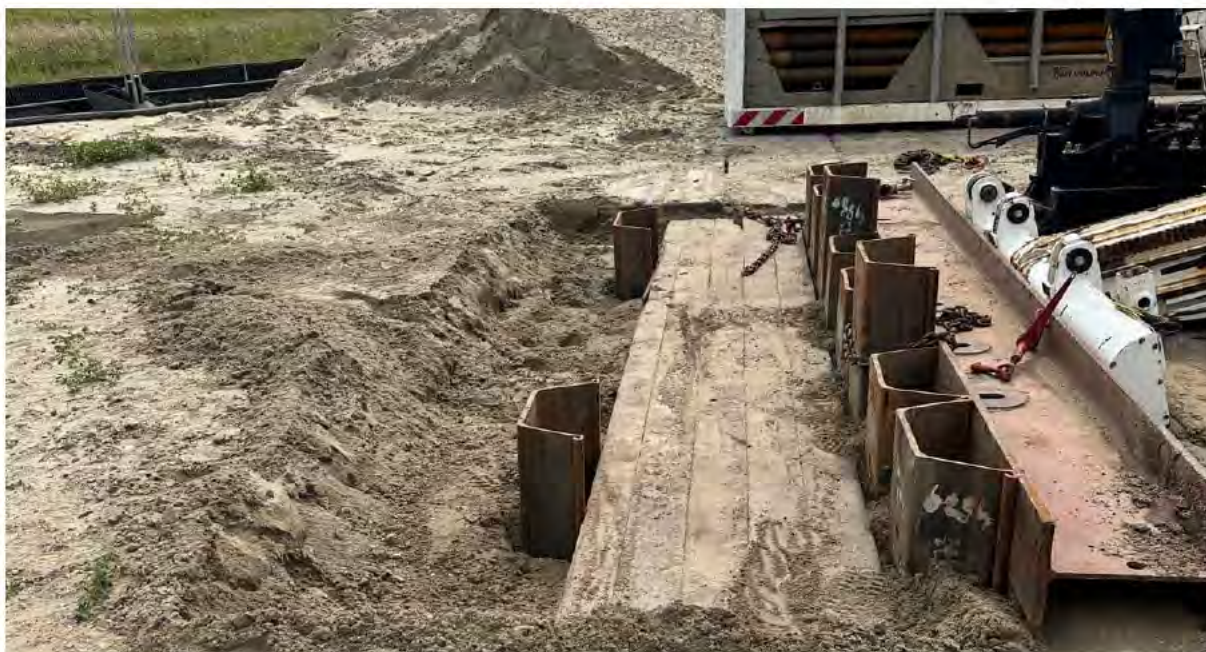
Figuur 17: Voorbeeld toegepaste verankeringswand
