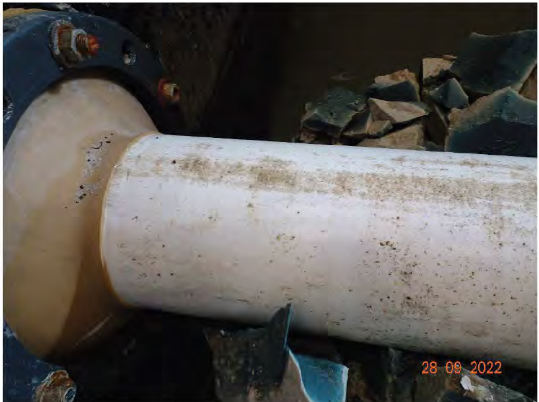
Figuur 4.4 Deel van de leiding dat zonder de omhullende Drill-Grout Plug is uitgetrokken.
