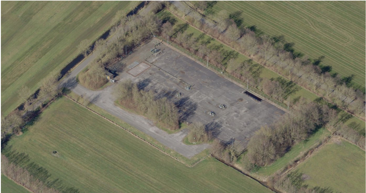
Figuur 2.2 Huidige mijnbouwlocatie TID 400 (Streetsmart by Cyclomedia 2025).
