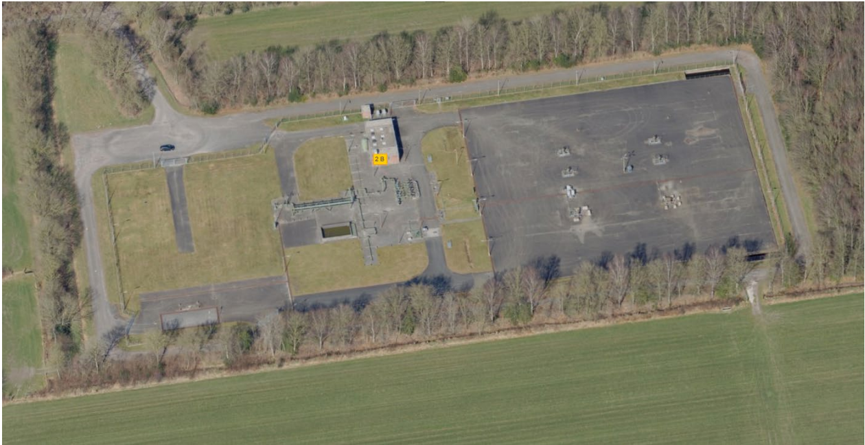
Figuur 2.2 Huidige mijnbouwlocatie TID-300 (Streetsmart by Cyclomedia 2025).
