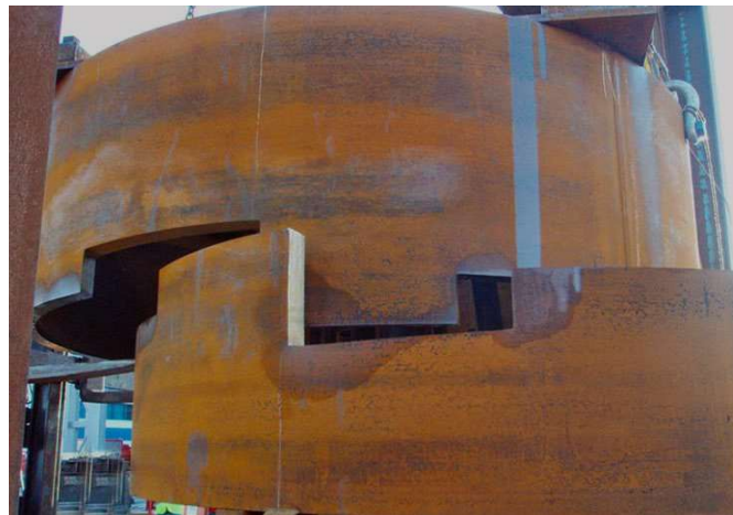
Figuur 10 (L) Inspectiegaten, (R) castellation cuts
