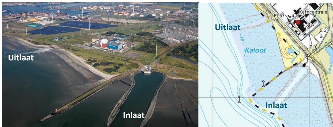
Figuur 5-10: Voorbeeld van open kanalen tussen strekdammen bij de huidige kerncentrale in Borssele. De inlaat is dieper dan de uitlaat.
