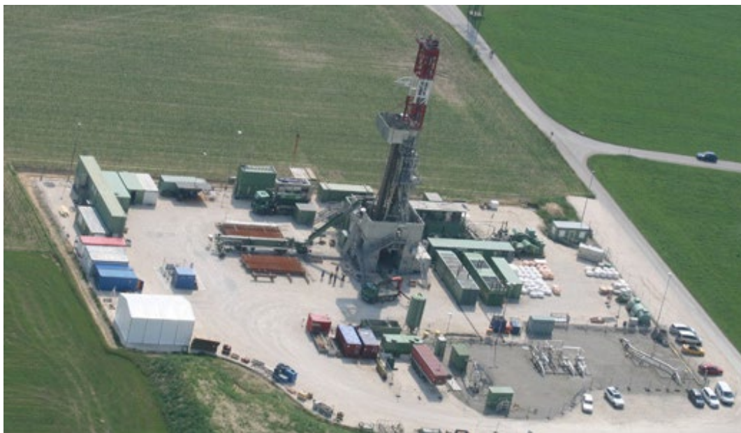
Figuur 3-1: Luchtfoto van de RED E200 mobiele boorinstallatie (RED, 2025) – en die naar verwachting ook ingezet wordt voor de diepboring(en) waarop deze toelichting voornemen betrekking heeft.
