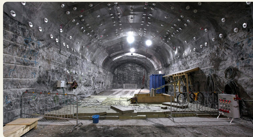
Ondergrondse eindberging in aanbouw (Finland)
