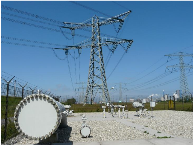
Afbeelding 5 - voorbeeld van een omheinde afsluiterlocatie met links de inspectiefaciliteit.
