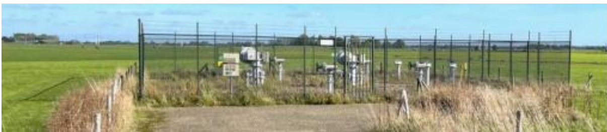
Afbeelding 4 - voorbeeld van een omheinde afsluiterlocatie.
