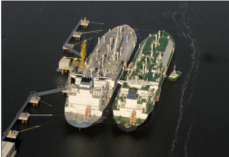
Figuur 2-1 Voorbeeld van een FSRU afgemeerd aan steiger en rechts de LNG-carrier (Bron: VTTI)
