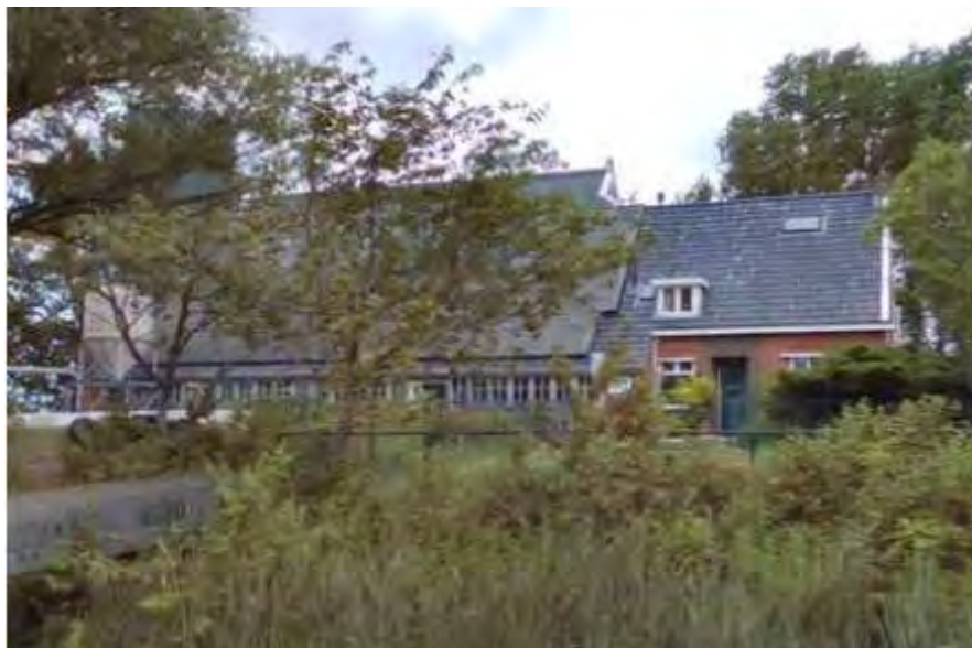
Figuur 8: Pand Damsterweg 4 (Delfzijl/Libau 2020)
