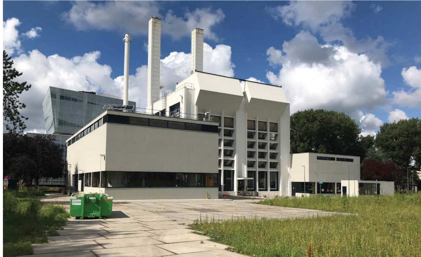
Zuidgevel Warmtekrachtcentrale, vanaf de Rotterdamse weg
