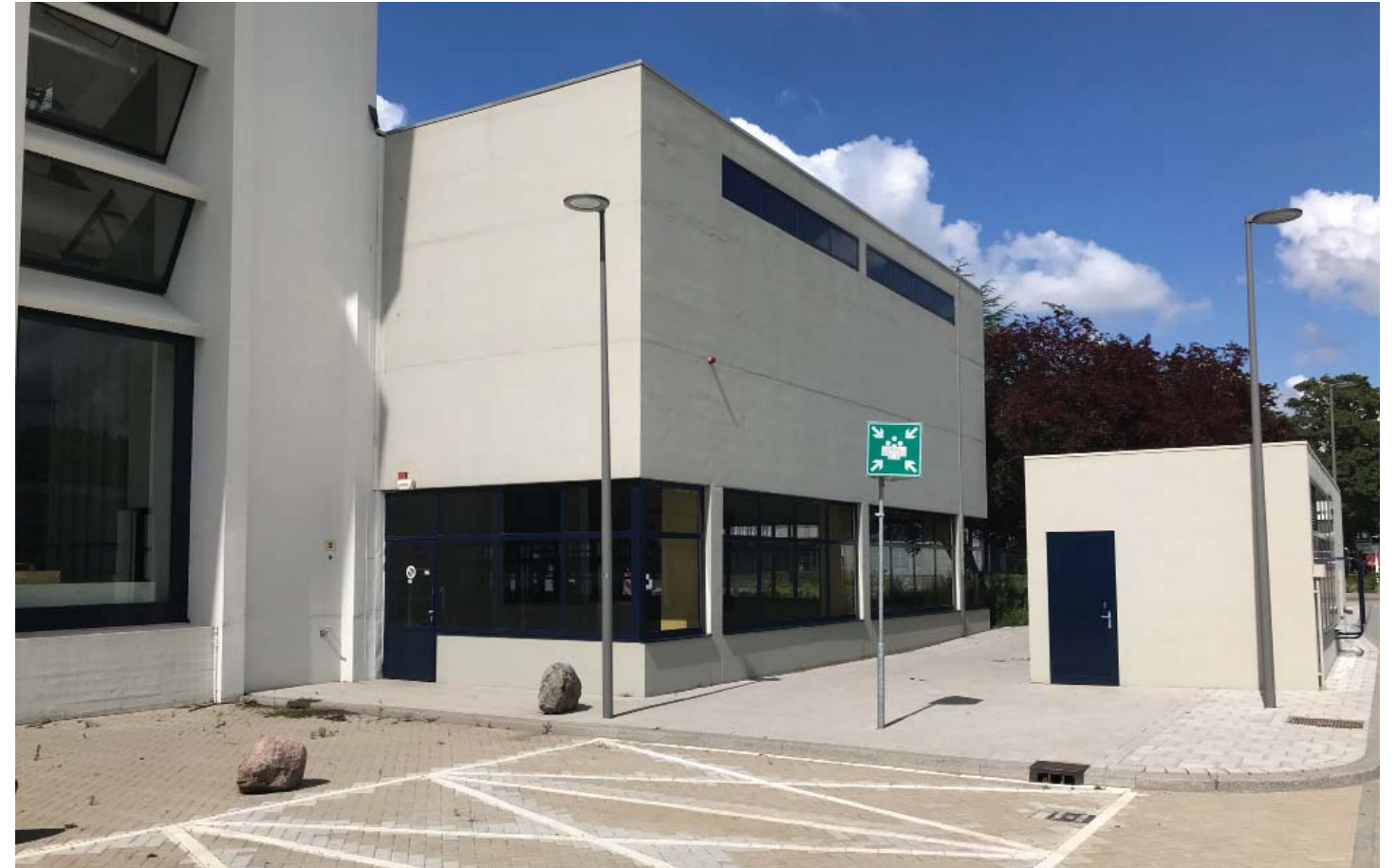
Detailopname van de echnische ruimten van de Warmtekrachtcentrale
