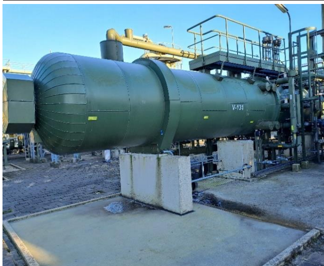
Objectnr. 9 V-131 Water/condensaat separator
