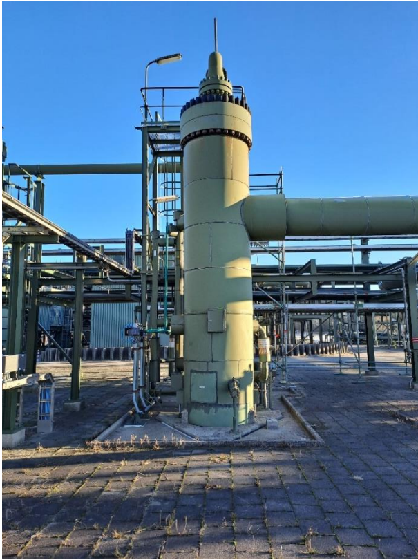
Objectnr. 1 V-102 Bulk separator
