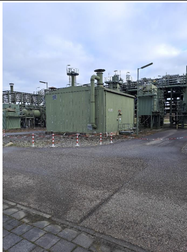
Objectnr. 93 K-270 Voormalig compressor gebouw
