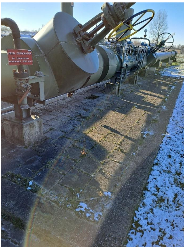
Objectnr. 7 V-117 Gas meter run
