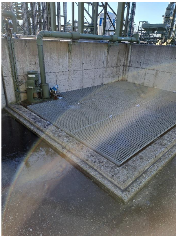
Objectnr. 34 V-074 AC bundwall drainpit
