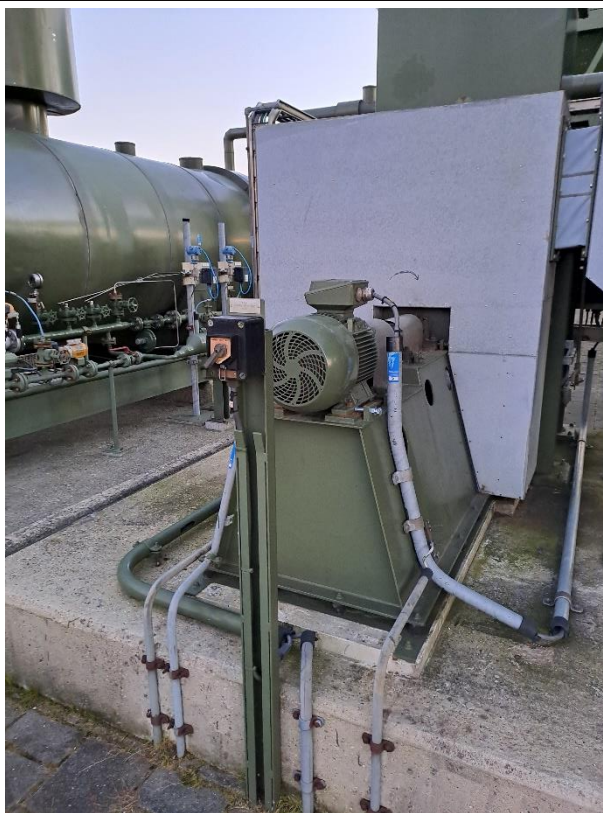
Objectnr. 24 K-125 Combustion air fan for F-122
