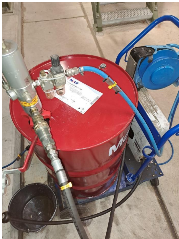
Objectnr. 131 Emballage in compressor gebouw K-570
