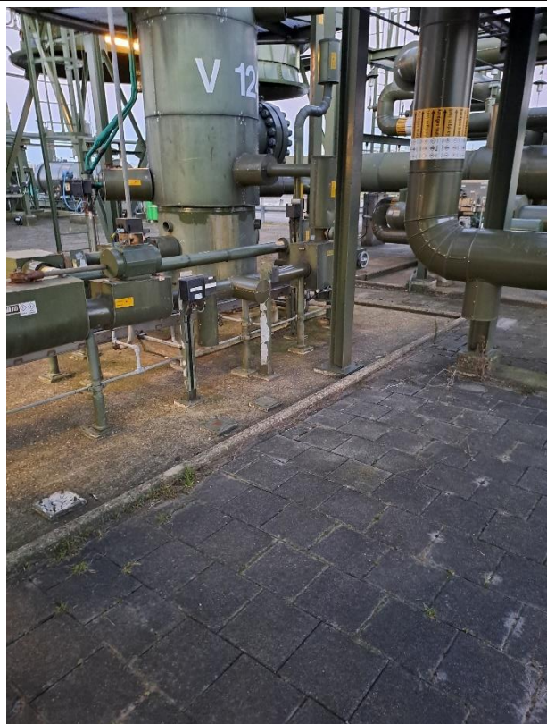
Objectnr. 8 V-124 Regeneration separator
