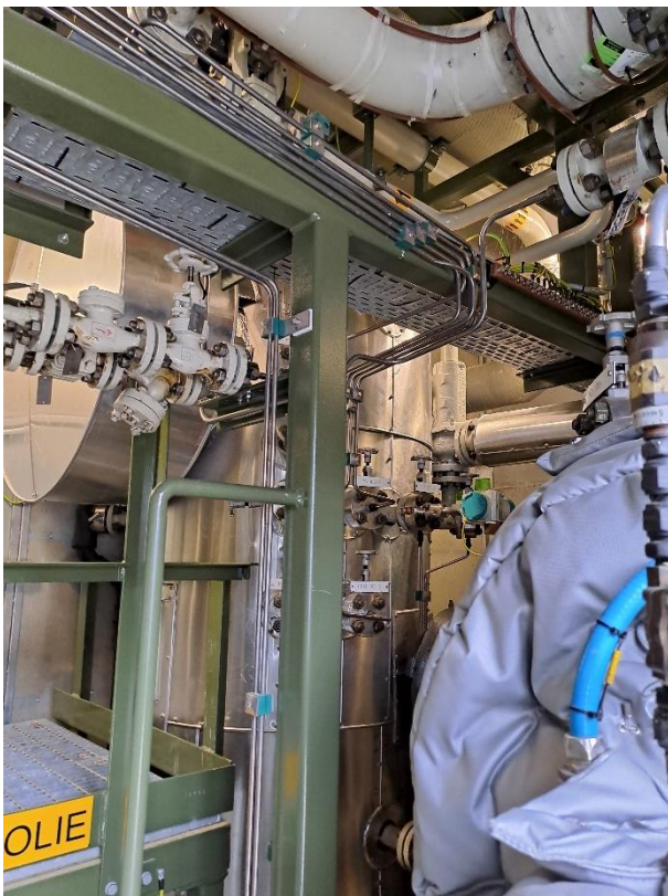
Objectnr. 84 V-103 Olie separator
