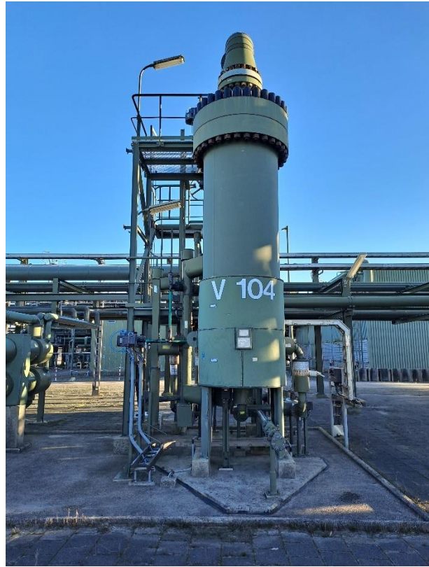
Objectnr. 2 V-104 Inlet separator
