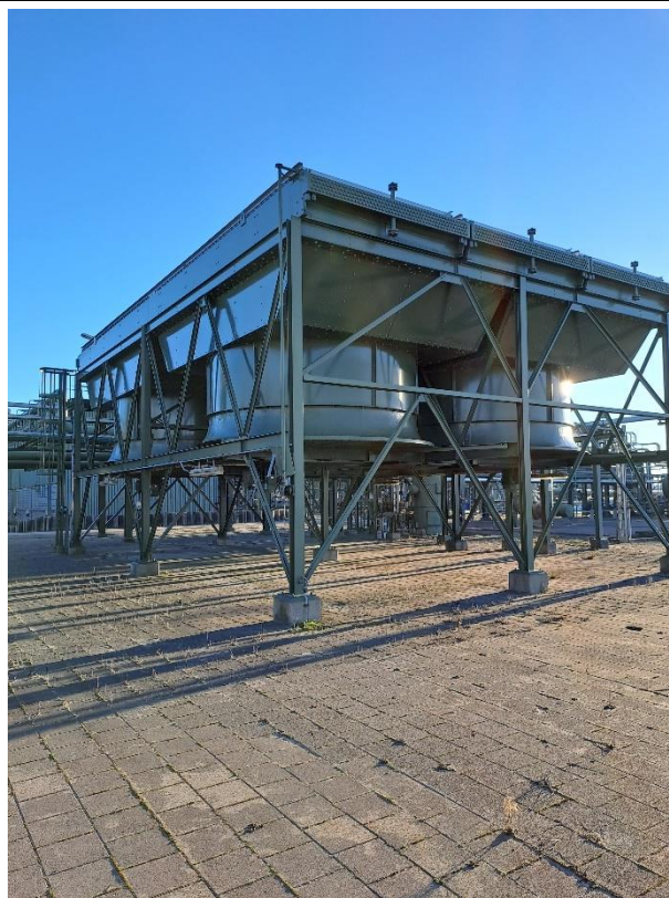
Objectnr. 15 E-103 Inlet cooler
