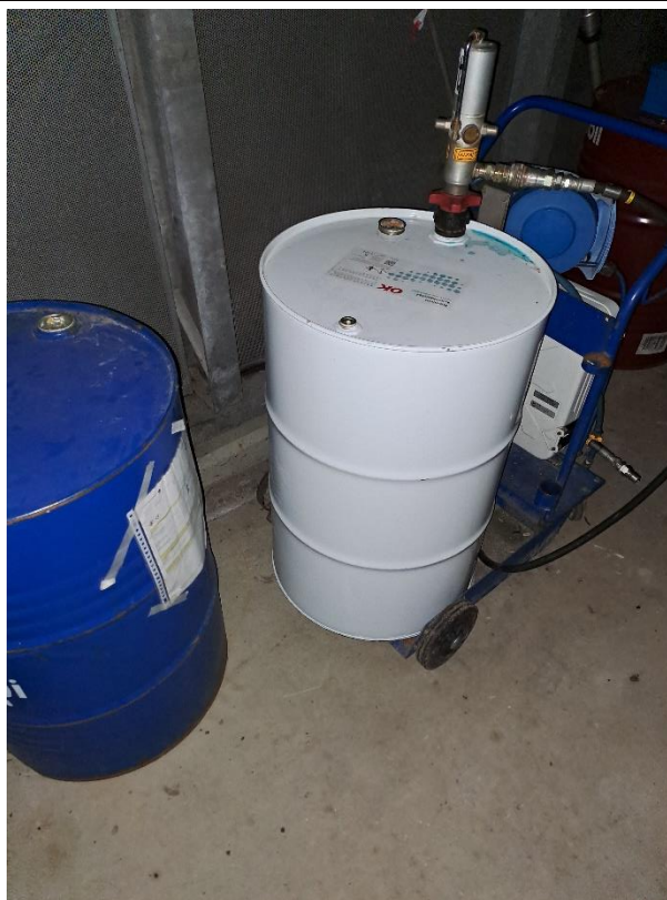
Objectnr. 99 Emballage in compressor gebouw K-170
