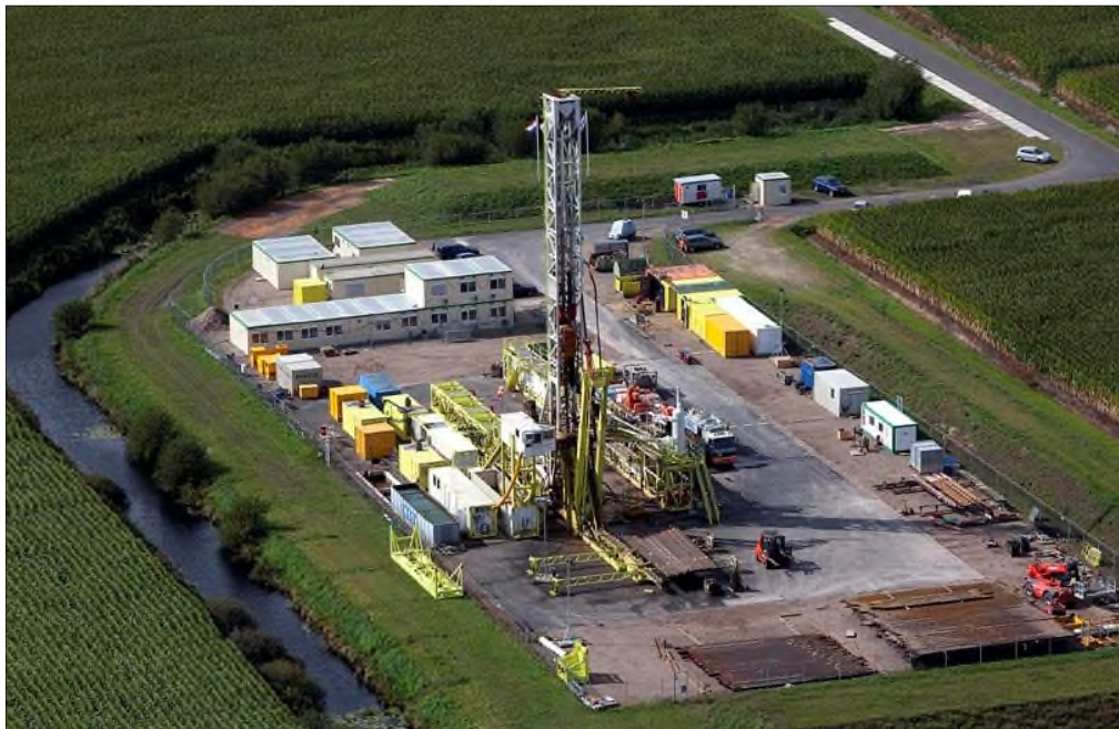
Figuur 3.3: Voorbeeld boorinstallatie zoals mogelijk in te zetten bij het GeoThermie Delft project
