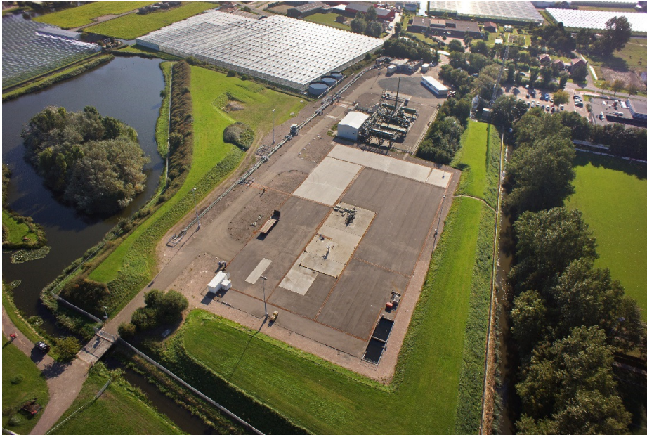
Figuur 3-3: De Monster puttenlocatie en behandelingsinstallatie
