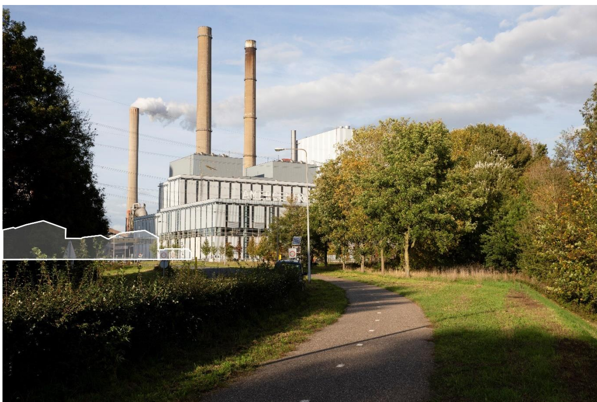
Figuur 6-31 Standpunt 3 - Locatie RWE terrein Noord
