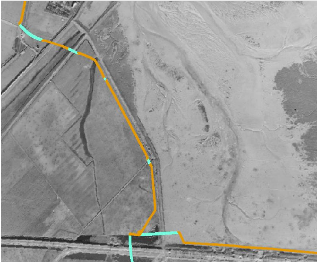
Figuur 2-37 Resultaat van geallieerde artillerie- en mortierbeschietingen op de Sloedam, ter hoogte van het landtracé. Datum luchtfoto: 4 november 1944.
