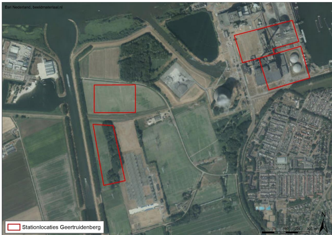
Figuur 8. De locaties van converterstation Geertruidenberg op een luchtfoto (2018).
