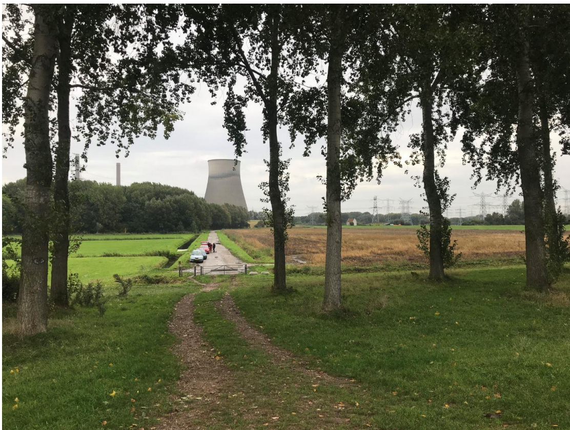
Figuur 9. Zicht op de koeltoren van de Amercentrale gezien vanaf kanaal de Amertak. Rechts van de weg locatie Standhazensedijk (foto Koos Mol d.d. 09-10-2019).
