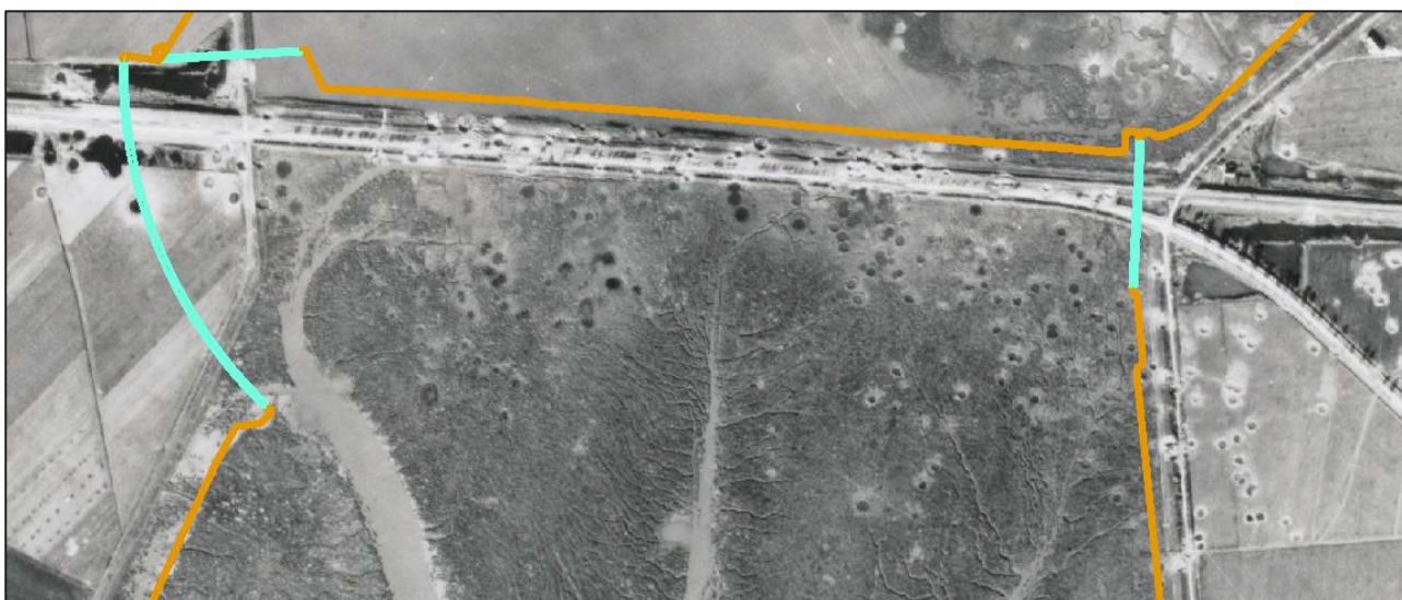
Figuur 2-36 Resultaat van verschillende geallieerde bombardementen op de Sloedam, ter hoogte van het landtracé. Datum luchtfoto: 14 oktober 1944.
