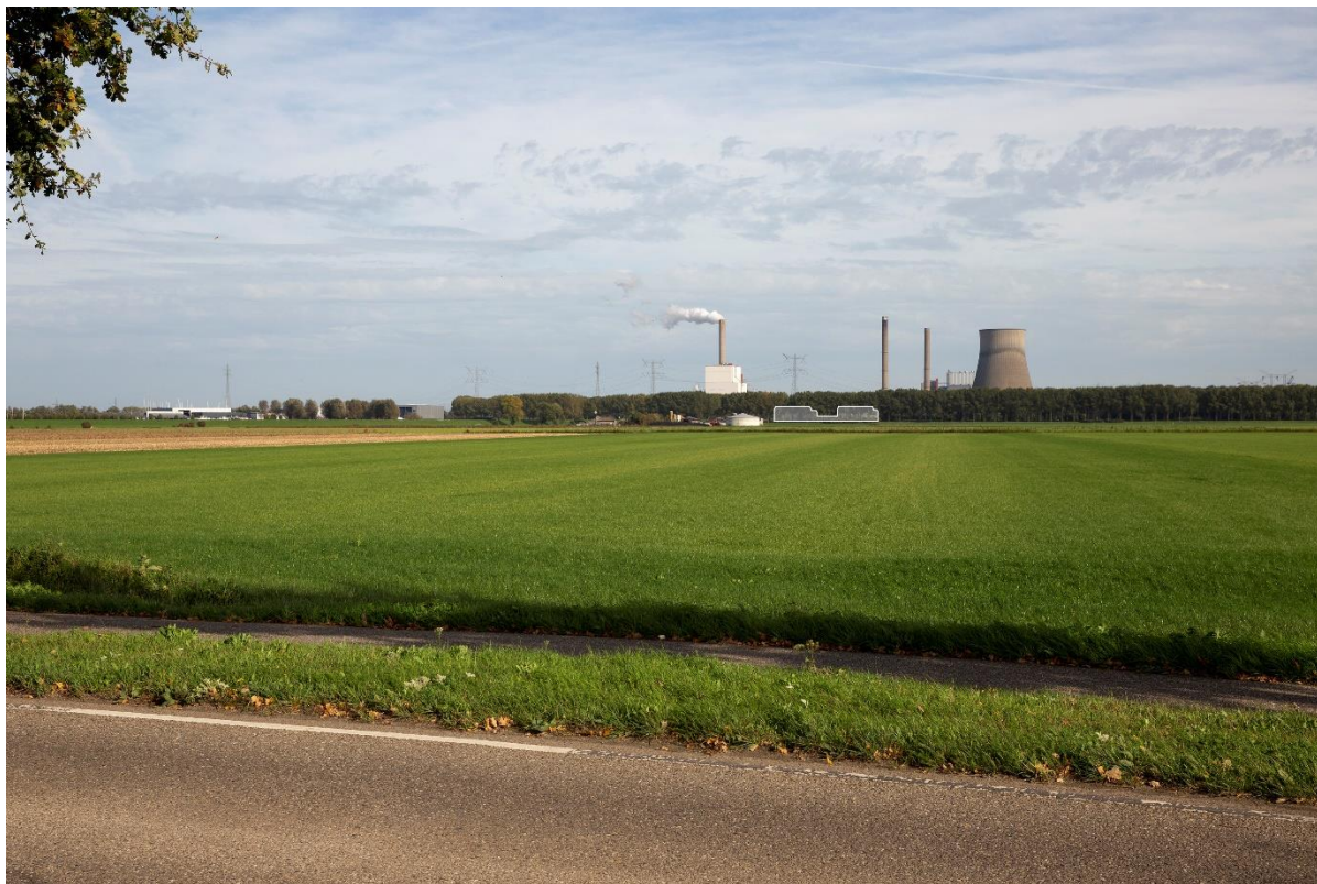
Figuur 6-28 Standpunt 2 - Locatie RWE terrein Noord
