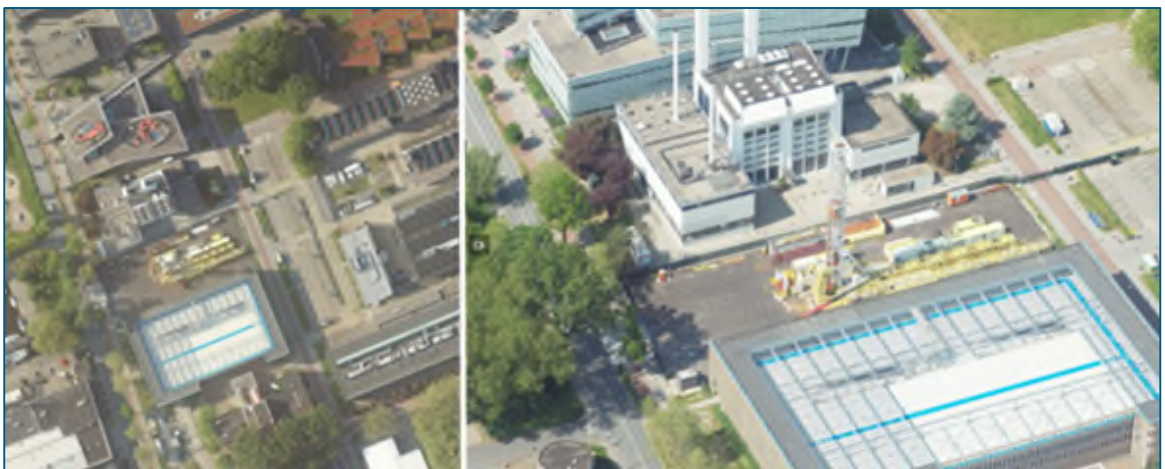
Figuur 1.2 Projectlocatie (perceel met mobiele boorinstallatie) ten tijde van geothermische boringen (bron: Streetsmart).
