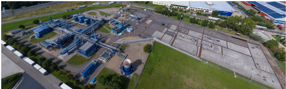
Figuur 3-4: Foto van de behandelingsinstallatie Gaag (GAG-2).
