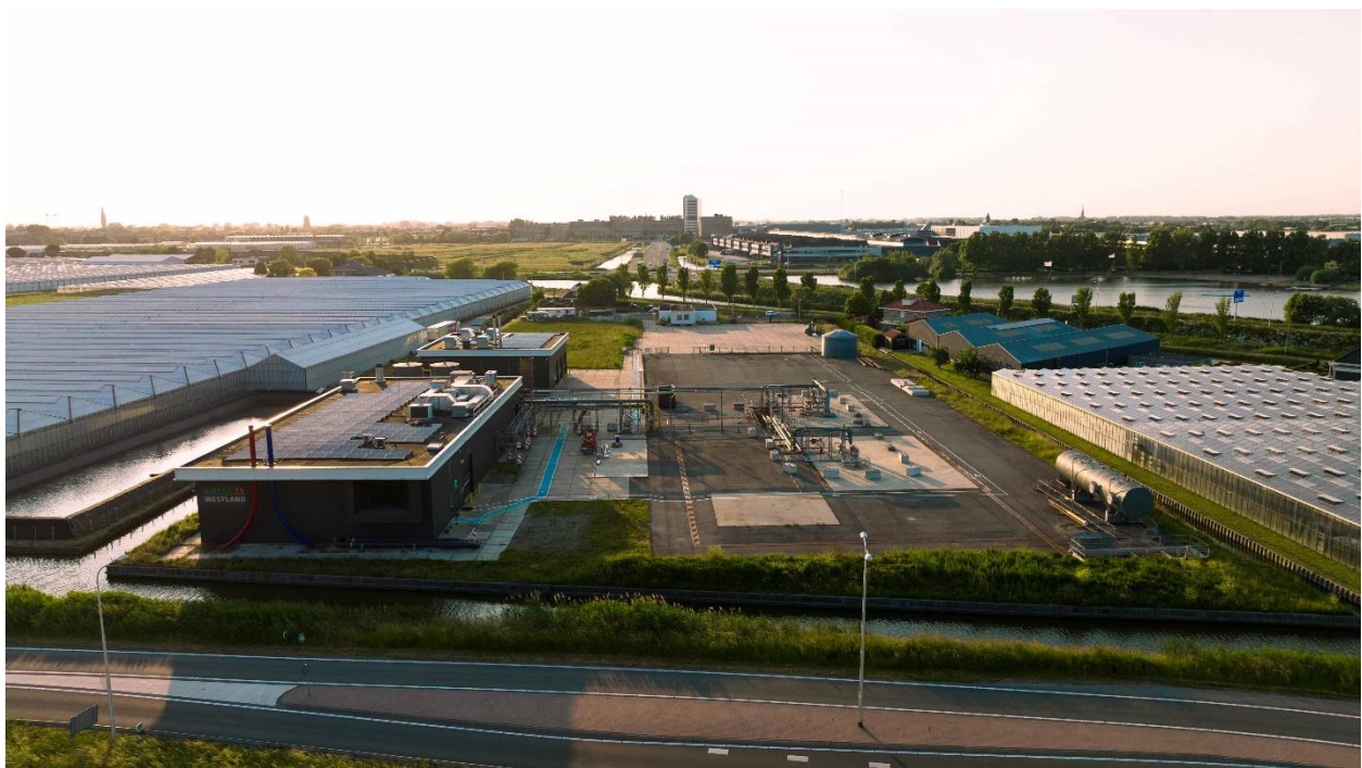
Figuur 9 Lay-out en foto van de mijnbouwlocatie
