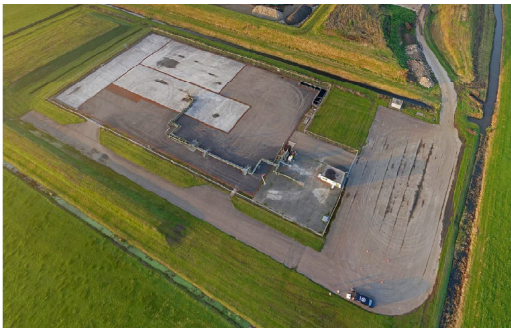
Figuur 3-2: Luchtfoto van productielocatie Oosterzand.
