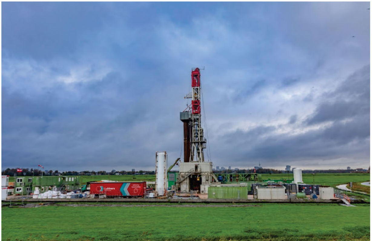
Figuur 3.3: Voorbeeld mobiele boorinstallatie (hier ter plaatse van de EBN SCAN boring Amstelland)
