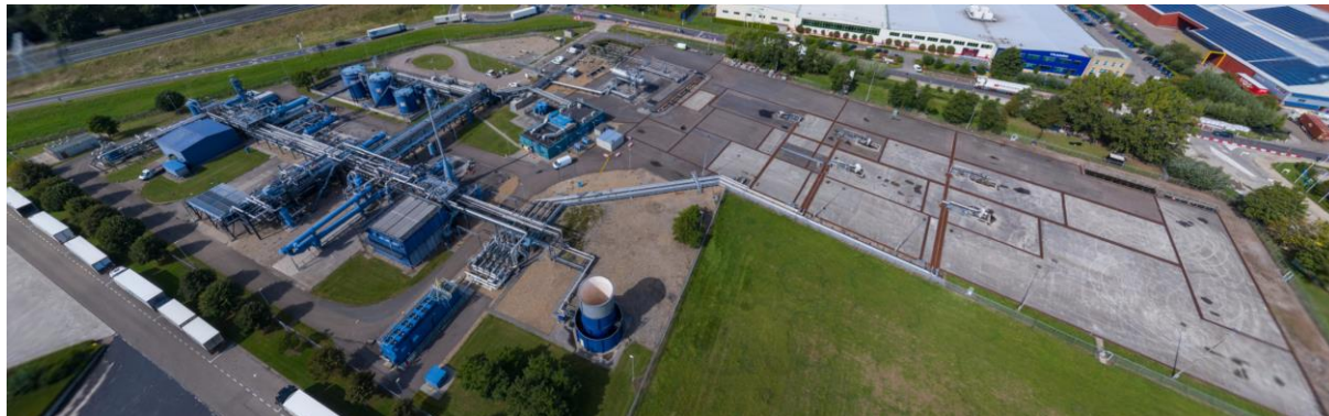
Figuur 3-4: Foto van de behandelingsinstallatie Gaag (GAG-2).
