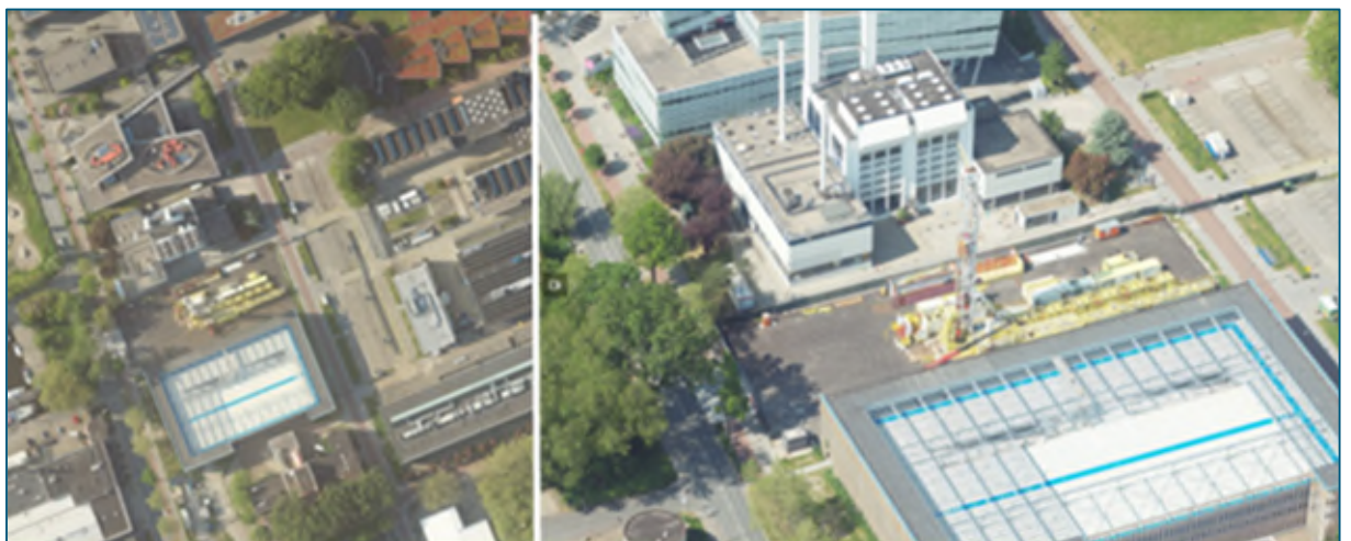
Figuur 3.2 Projectlocatie (perceel met mobiele boorinstallatie) ten tijde van geothermische boringen (bron: Streetsmart).
