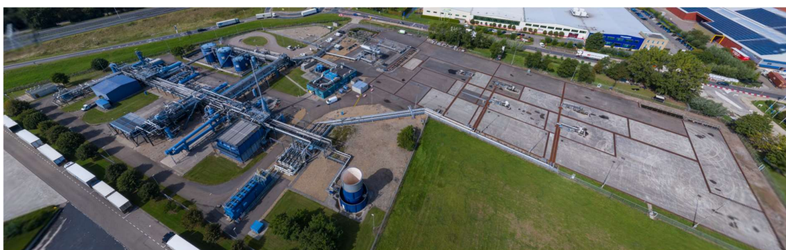
Figuur 3-3: Foto van de productie en behandelingsinstallatie Gaag (GAG)
