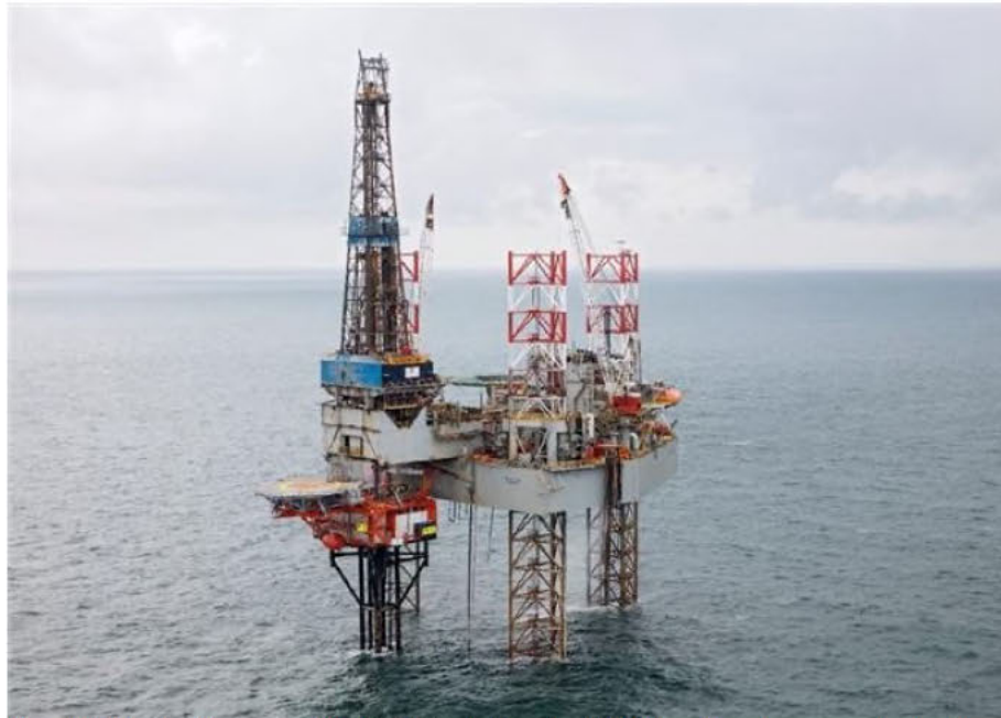
Figuur 3.3: Voorbeeld van een zelfheffend boorplatform (rechts) tijdens uitvoering van een boring bij een satellietplatform (links)
