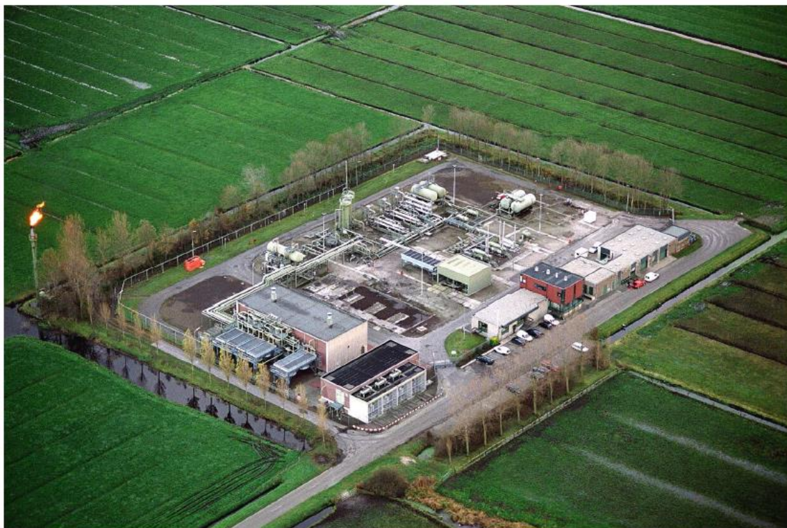
Figuur 2-3: Luchtfoto van het Garijp Gasbehandeling Station (GTC).
