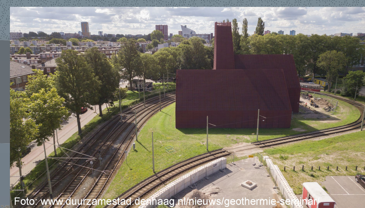
Foto: www.duurzaamestad.nl/nieuws/geothermie-ehaag/ Eerste aardwarmte productie-installatie voor verwarming van gebouwde omgeving in Den Haag.
