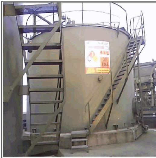
ObjectNr: 13 Bedrijfsactiviteit: T-3 water/aardgascondensaat opslagtank (buiten gebruik)
