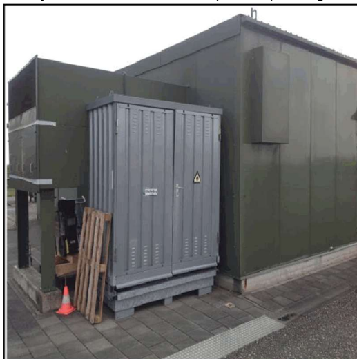
ObjectNr: 58 Bedrijfsactiviteit: Chemicalienopslag /smeerolieopslag (buiten gebruik)
