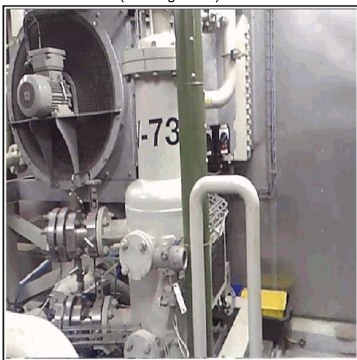
ObjectNr: 49 Bedrijfsactiviteit: V-73 Vloeistofafscheider (buiten gebruik)
