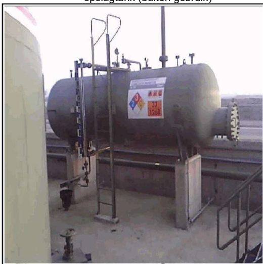
ObjectNr: 14 Bedrijfsactiviteit: V-19 Anti-corrosievloeistof opslagvat (buiten gebruik)
