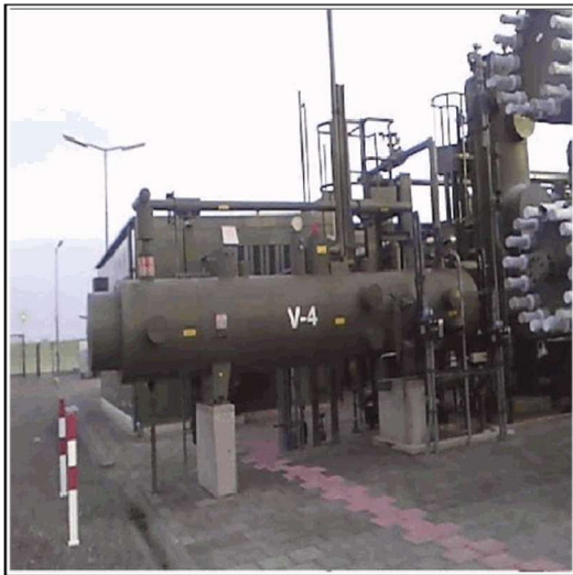
ObjectNr: 30 Bedrijfsactiviteit: V-4 Water/aardgascondensaatscheider (buiten gebruik)
