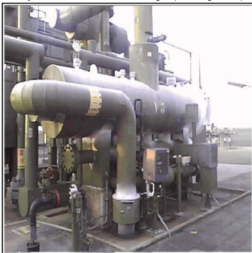
ObjectNr: 28 Bedrijfsactiviteit: V-3 Filter afscheider (buiten gebruik)
