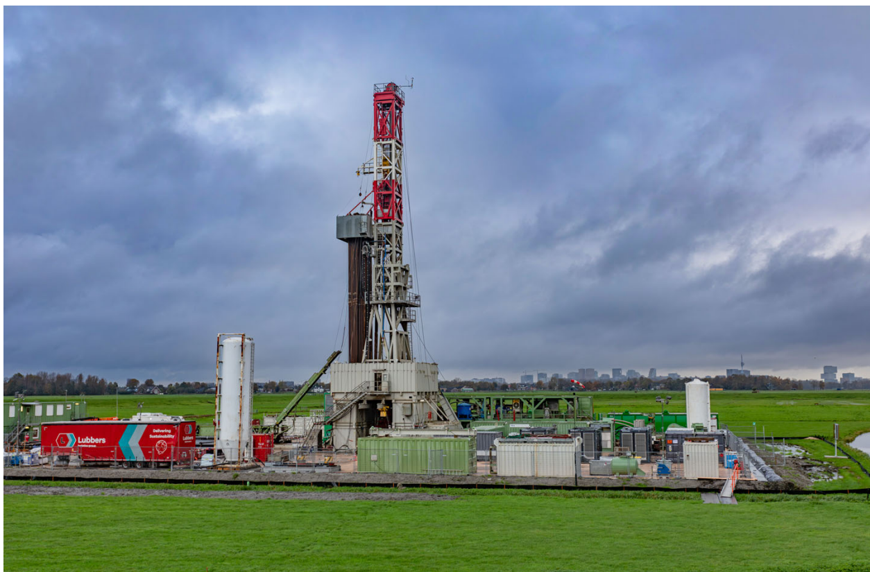
Figuur 3-3: Impressie van boorinstallatie bij daglicht. Dit betreft een SCAN boring bij Ouder-Amstel in 2023.
